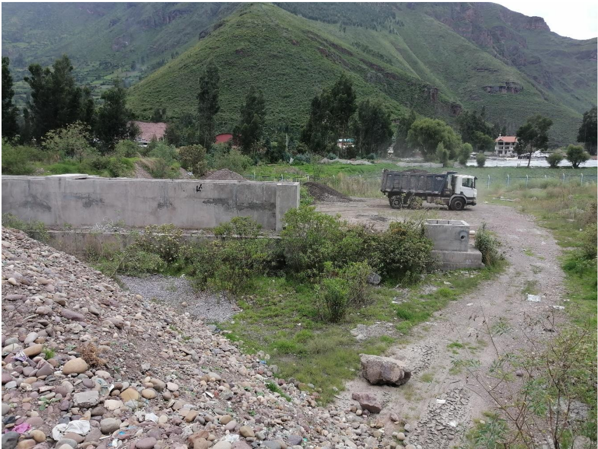
Ilustración 24 Movimiento de tierras.
