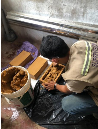
Ejecución de la elaboración de bloques
