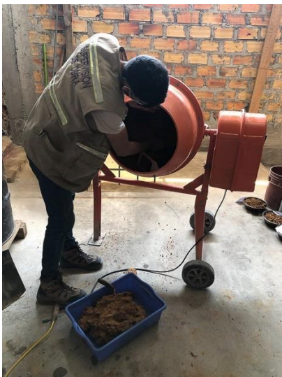
Extracción de la mezcla del trompo
