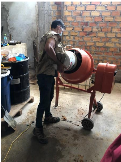
La dosificación de materiales se hacía directamente en el trompo
