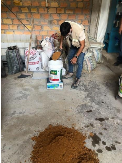
Pesaje de material para la dosificación
