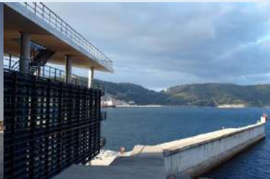
EDIFICIO DE CONTROL CCS . ESPAÑA
