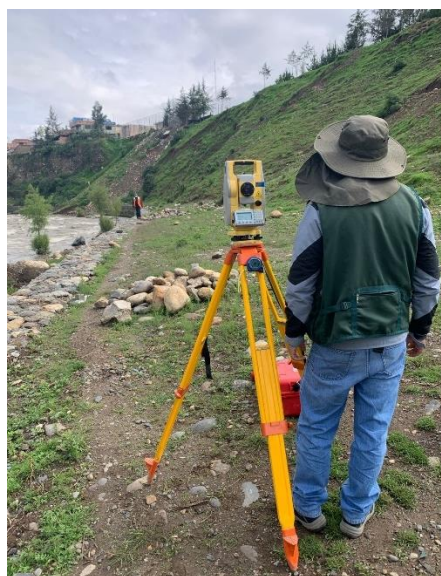
Figura 23. Levantamiento topográfico del talud.
