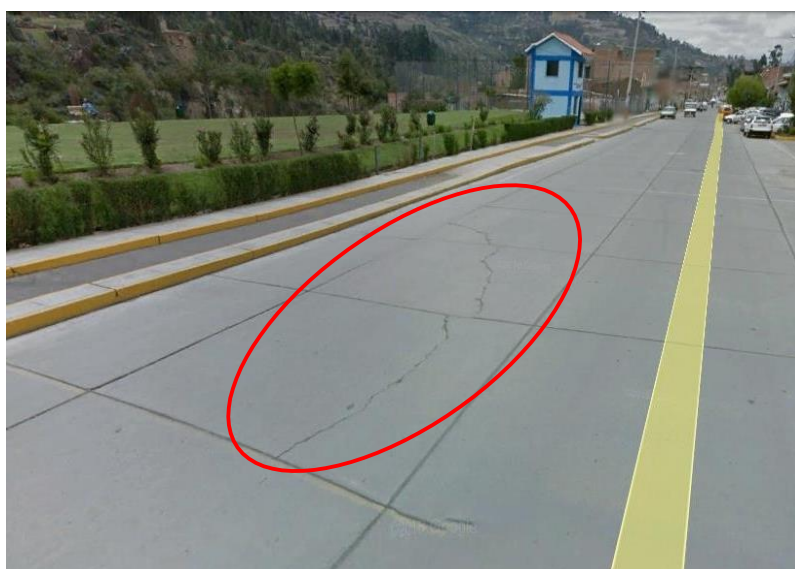
Figura 22. Pavimentado aledaño al parque El Milagro.
