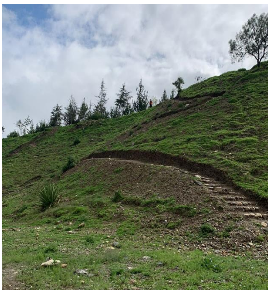
Figura 21. Zona 02: Vista Frontal del talud.
