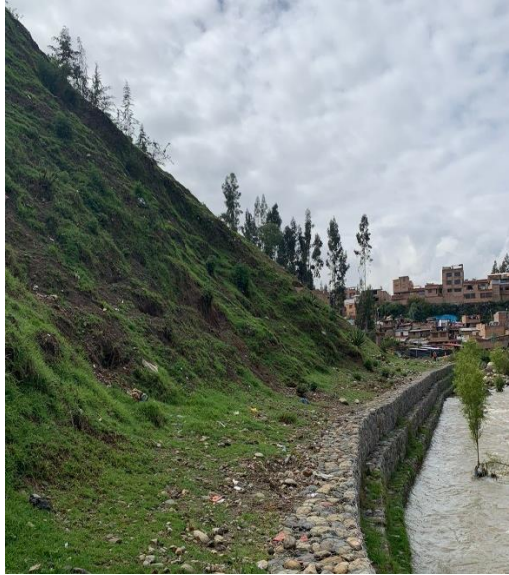
Figura 19. Zona 01: Vista lateral del talud.
