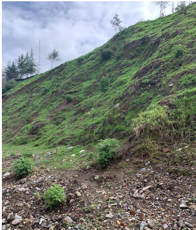
Figura 20. Zona 01: Pie del talud.
