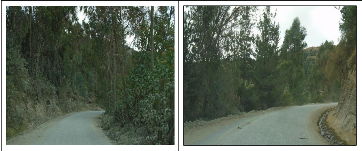
Figura 8. Drenaje y cunetas de la plataforma km 70+000 – km 75+000
