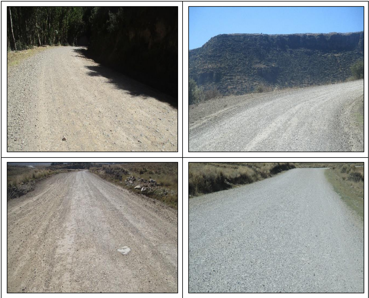
Figura 6. Topografía de la carretera km 70+000 - km 75+000
