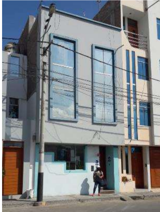
Imagen N° 07: Vivienda unifamiliar de 3 pisos con el sistema AC.
