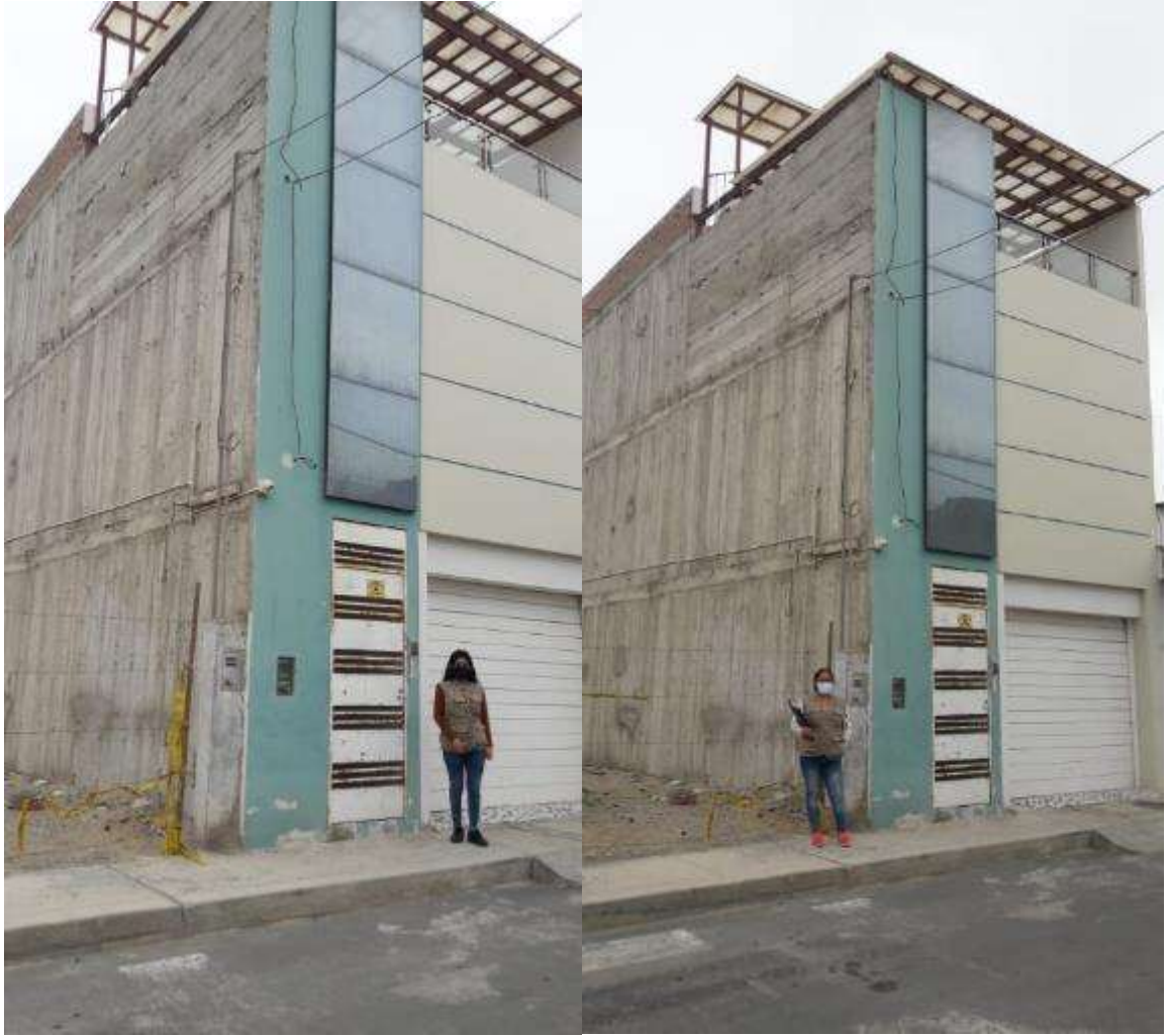
Imagen N° 03: Vivienda unifamiliar de 3 pisos con el sistema MDL.
