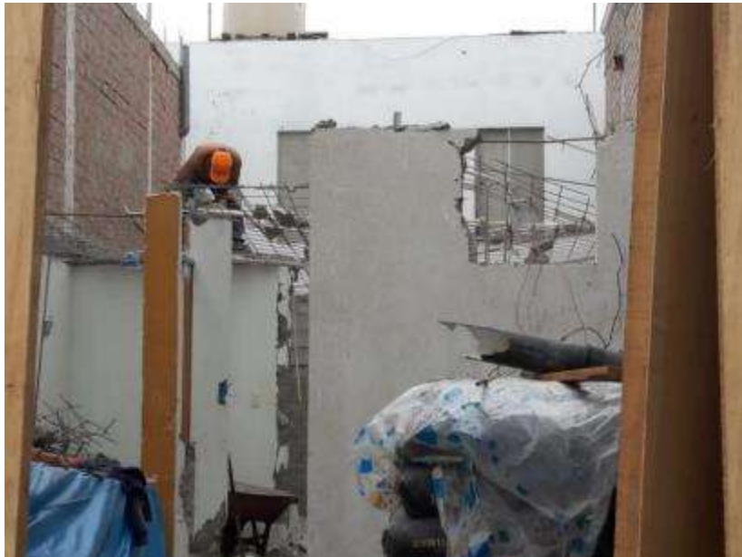
Imagen N° 26: Se puede observar que están modificando el módulo de MDL para una reconstrucción con el sistema tradicional.
