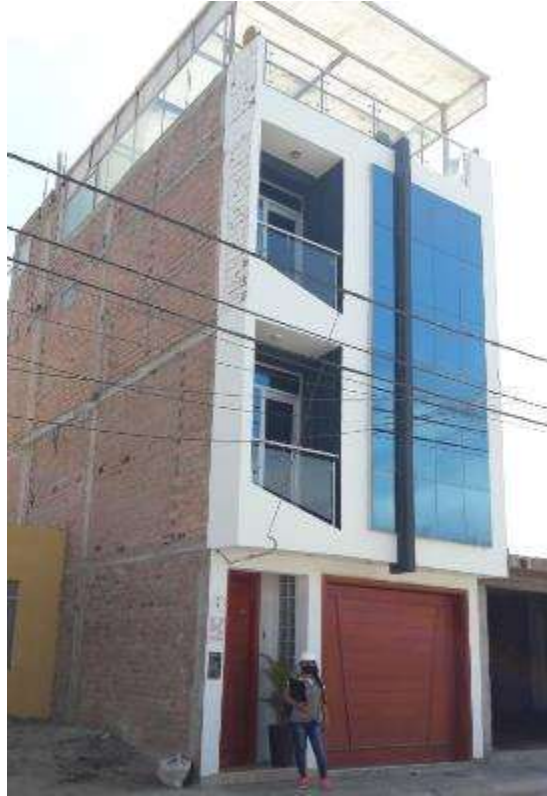
Imagen N° 13: Vivienda unifamiliar de 3 pisos con el sistema A.C.
