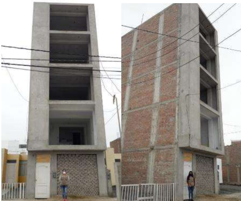
Imagen N° 24: Vivienda multifamiliar de 5 niveles con el sistema de albañilería confinada.
