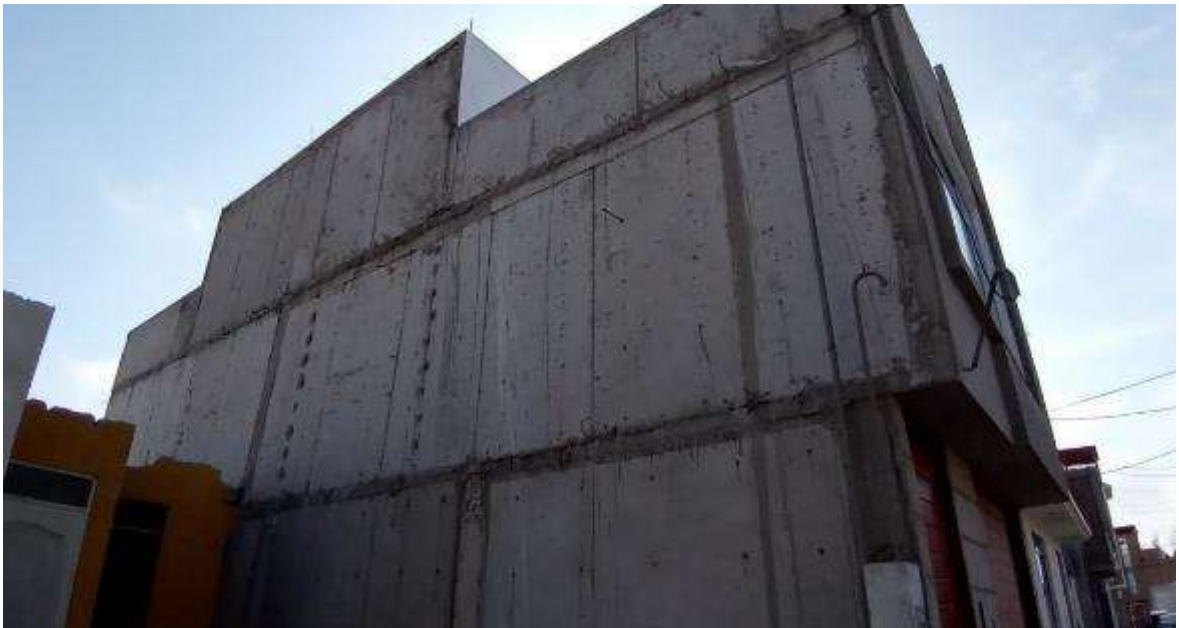
Imagen N° 04: Vivienda unifamiliar de 3 pisos con el sistema MDL.
