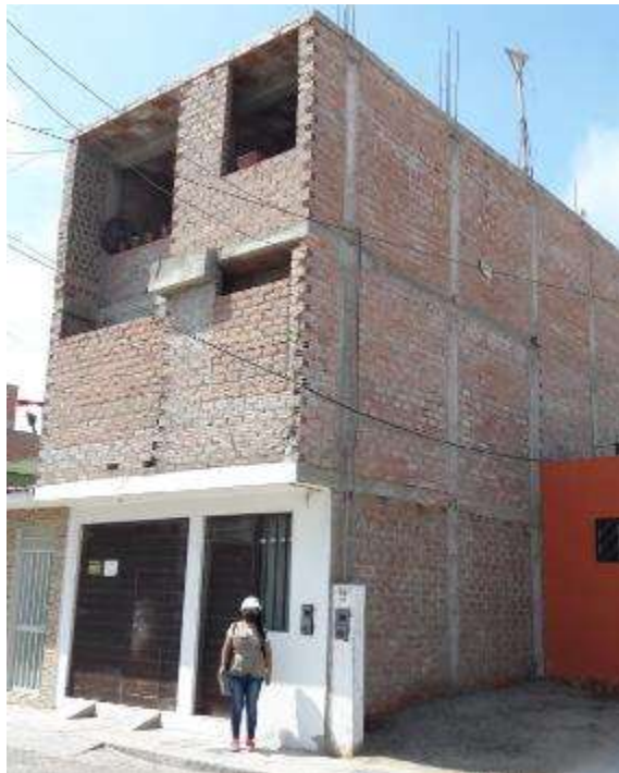
Imagen N° 10: Vivienda unifamiliar de 3 pisos con el sistema A.C.
