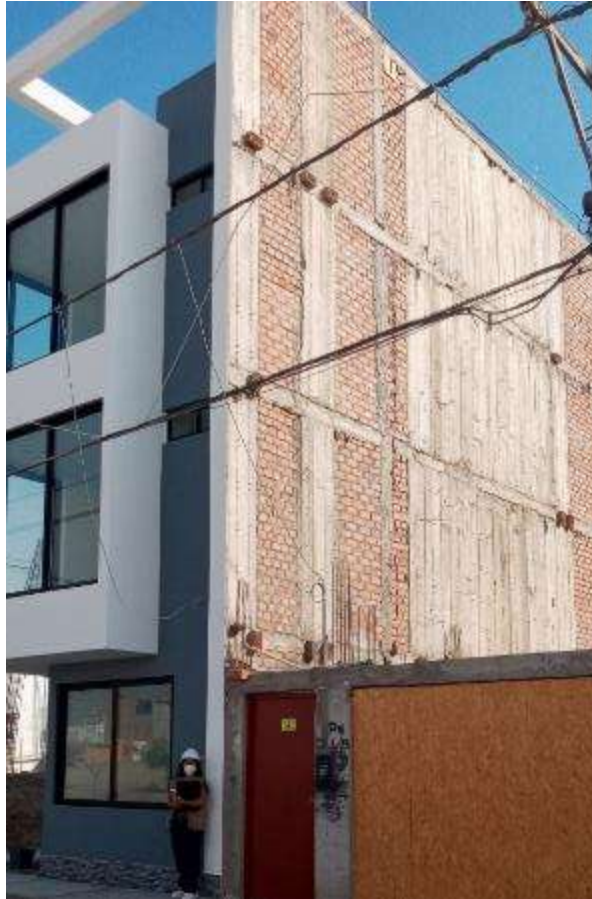
Imagen N° 25: Vivienda unifamiliar de 4 pisos con el sistema A.C y MDL
