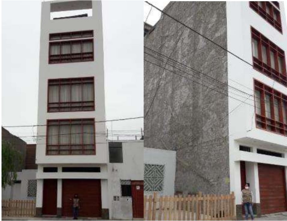
Imagen N° 23: Vivienda multifamiliar de 4 niveles, con el sistema de albañilería confinada cubierto por una capa de mortero.
