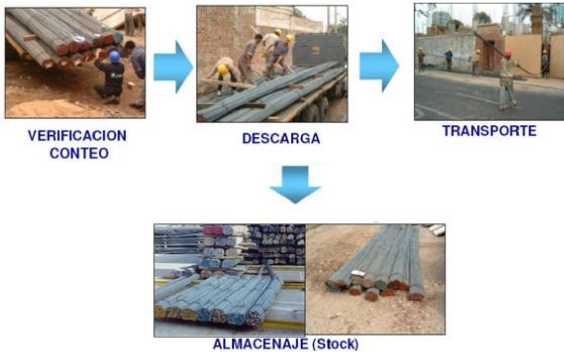
Figura 5: Flujograma - recepción de acero corrugado
