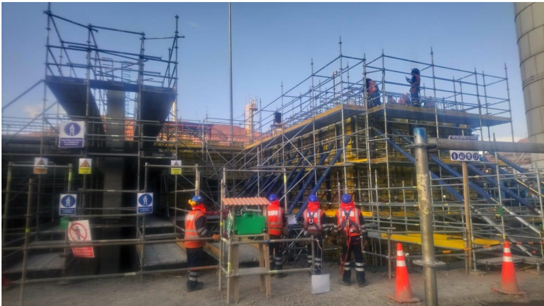
Figura 17: Encofrado de muros.
