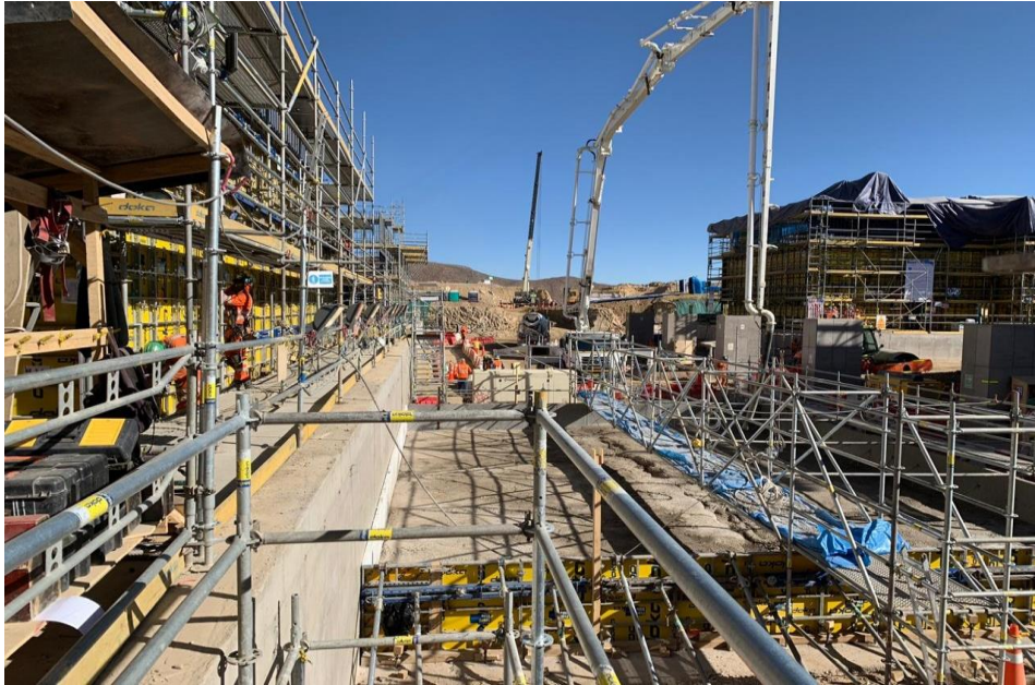
Figura 16: Colocación de andamios para verter el concreto.
