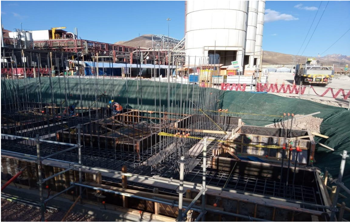
Figura 18: Colocación acero en sala eléctrica del proyecto Toromocho.
