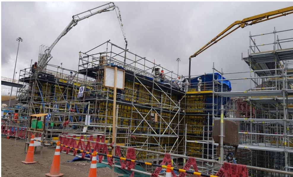
Figura 21: Vaciado de concreto premezclado en muros de Sala Eléctrica.
