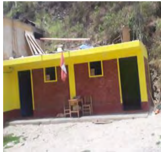
Imagen 18: Depósito general de los baños termales de Chancos.
