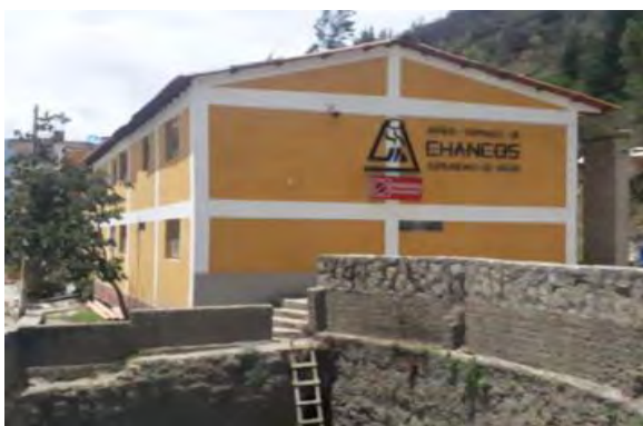
Imagen 35: Concreto ciclópeo en muros bajos.
