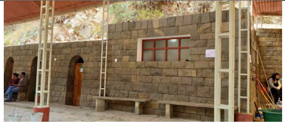
Imagen 11: Los materiales usados en las cuevas, el enchapado es de piedra, las bancas en esta zona son de granito, la estructura del techo es metalica con cobertura de polipropileno, los materiales de
