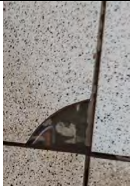
Imagen 16: Interior de las pozas, mayólicas rotas.
