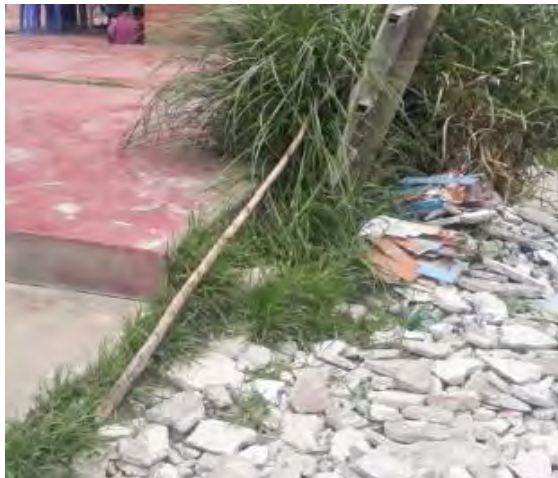
Imagen 7: Áreas sin pavimentar u ocupadas por desechos.
