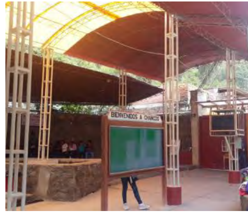
Imagen 22: Cobertura de polipropileno sostenida por estructura metálica.
