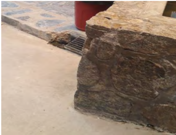
Imagen 35: Concreto ciclópeo en muros bajos.
