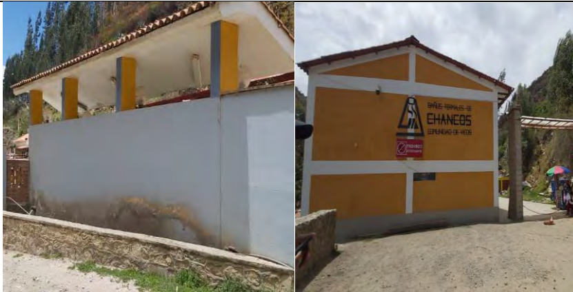
Imagen 10: Se observa que los materiales usados en la mayor parte de la edificación es de material de concreto y albañearía confinada, las cubiertas son de tejas artesanales, los pisos son pavimentos de concreto en ciertas partes, pero en el ingreso se denota la presencia
