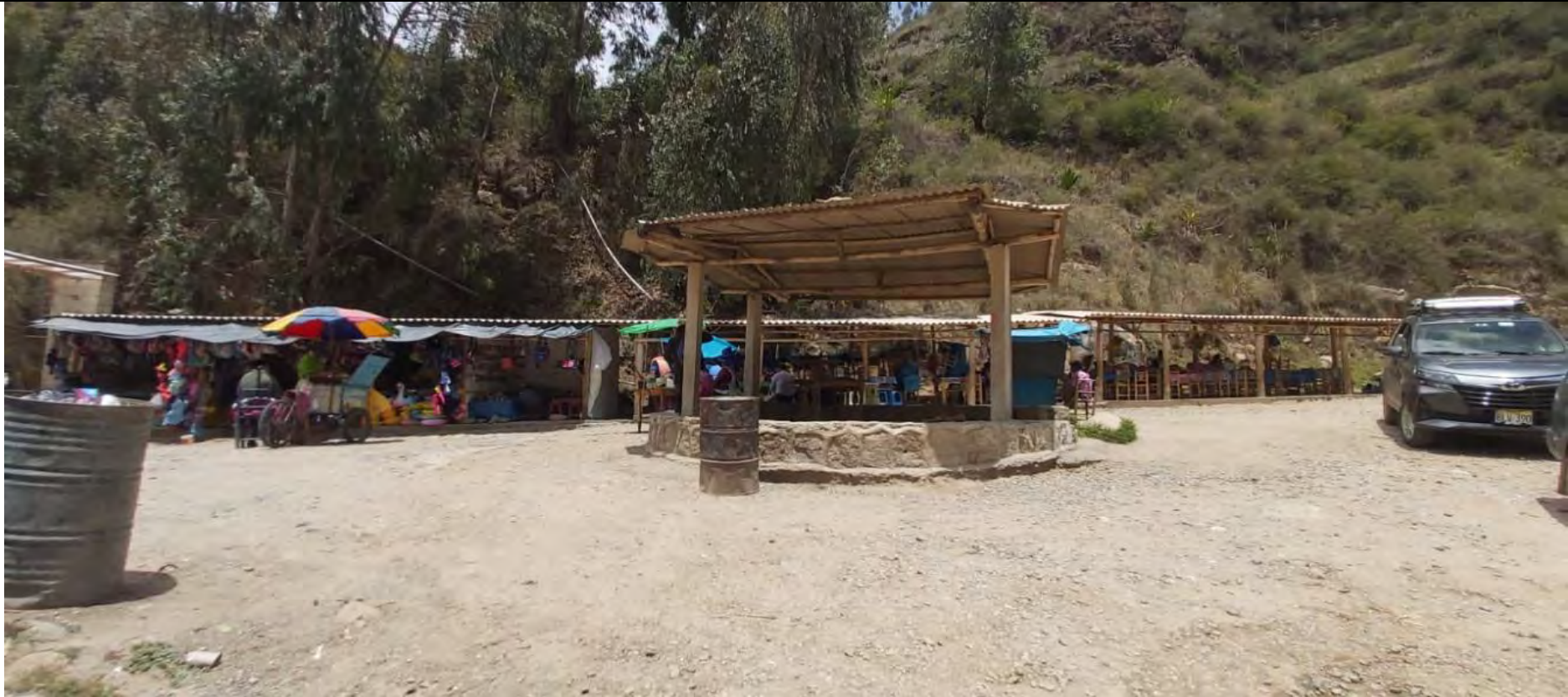
Imagen 29: Área de comidas, estructura de madera realizadas por los pobladores, con cubierta de eternit. El paradero con columnas de concreto y cubierta de eternit. Considerada zona de estacionamiento, el polvo que se genera por los carros invade la comida que se oferta.
