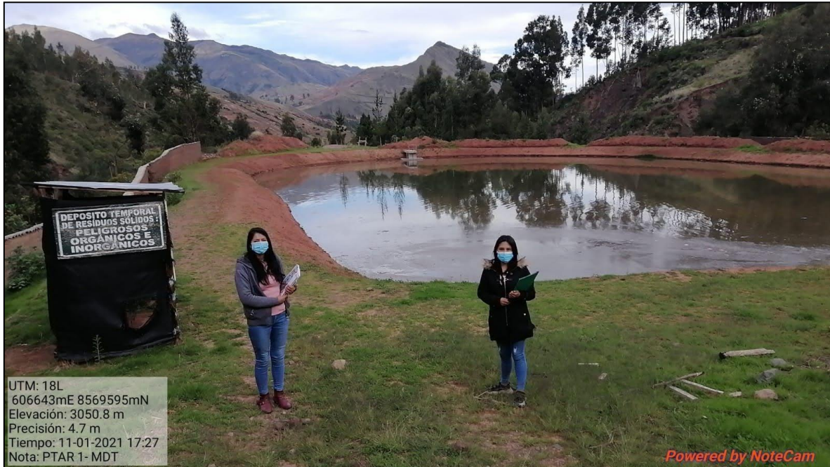
Fotografía 07: Planta de aguas residuales del Distrito de Tambo.
