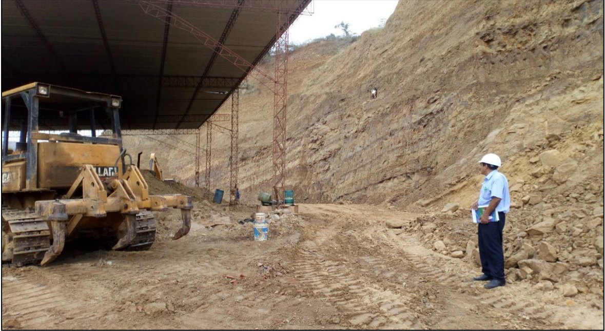
Figura 01. Extracción de la materia prima con excavadora en cantera.
