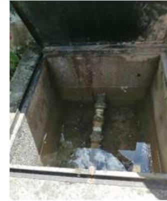
Foto 15. Fugas en las cajas de válvulas del sistema actual
