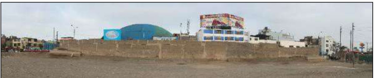
Figura 7. Vista panorámica oeste a este de la muralla en el Sector B de Mateo Salado. Sialer, 2017.
