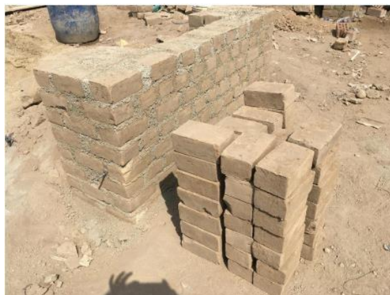
Figura N° 2 Construcción de viviendas con adobe
