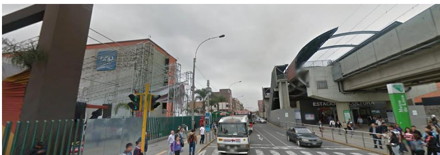
Figura 87: Vista a la Biblioteca Nacional frente a la estación “La Cultura”
