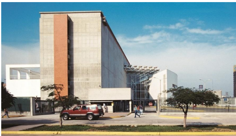
Figura 90: Fachada Principal (Biblioteca Nacional del Perú)
