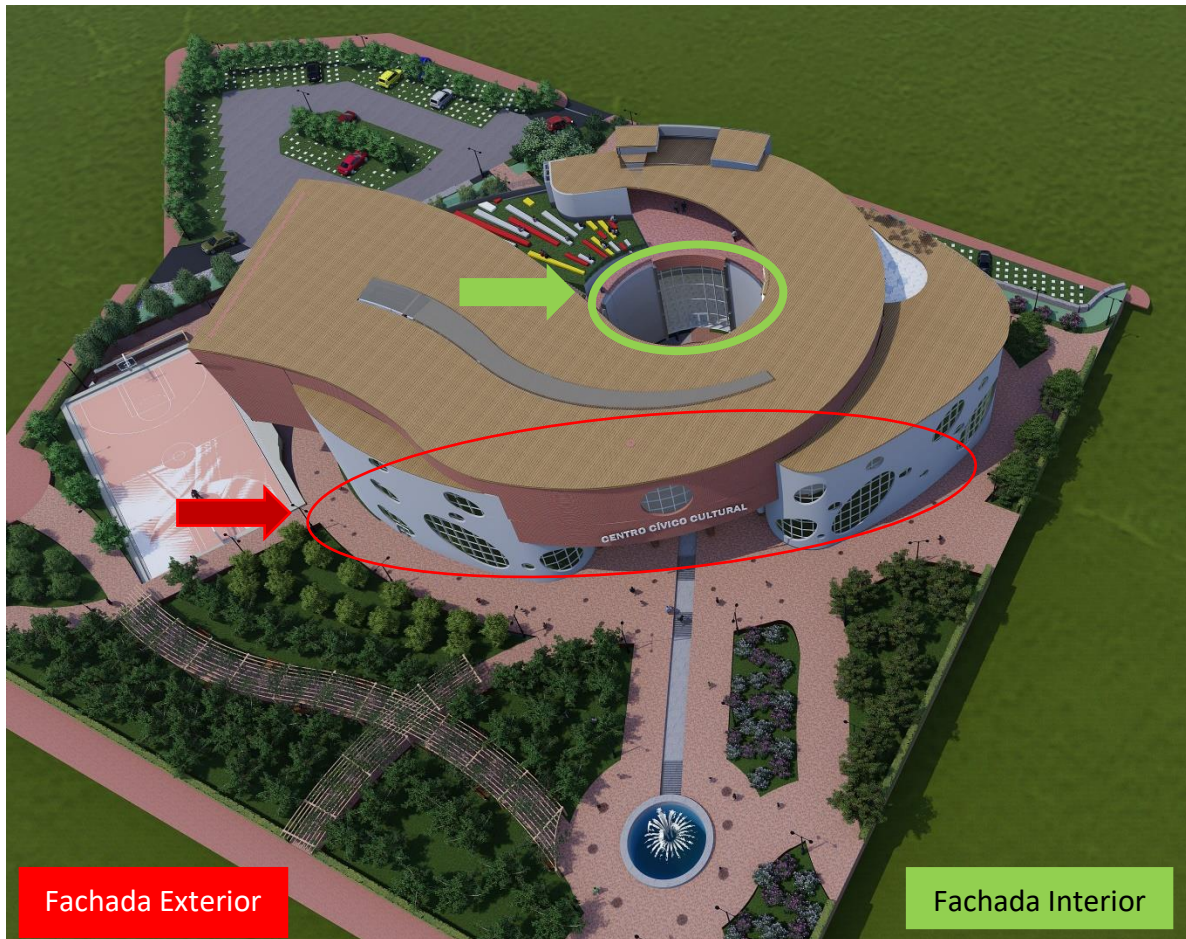
Figura 194: Ubicación de dobles fachadas (vista en planta)
