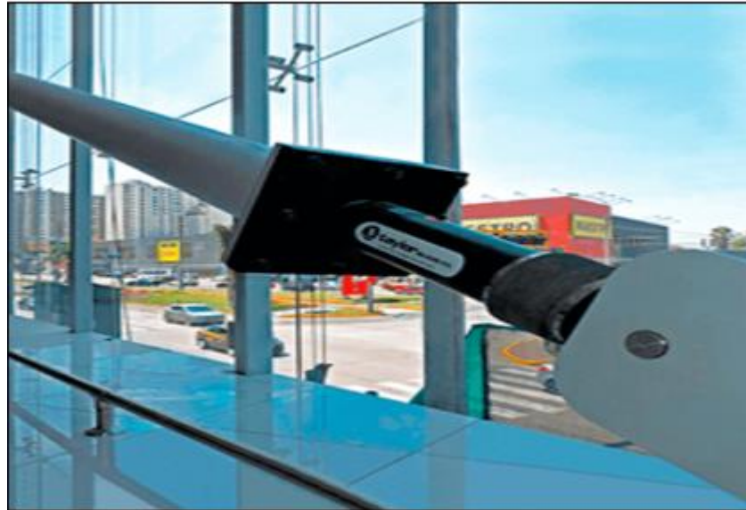
Figura 5. Disipador de fluidos viscosos Taylor
