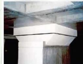
Caja de fuego a bordo protegé el aislador en Condominio Kamikuzawa.
