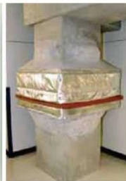
Se utilizaron mantas ignífugas en el Channing House
