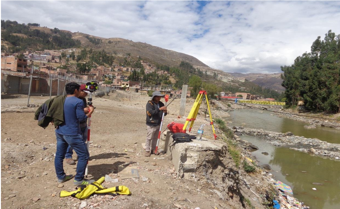
Fotografía 03: inicio de los trabajos de topografía
