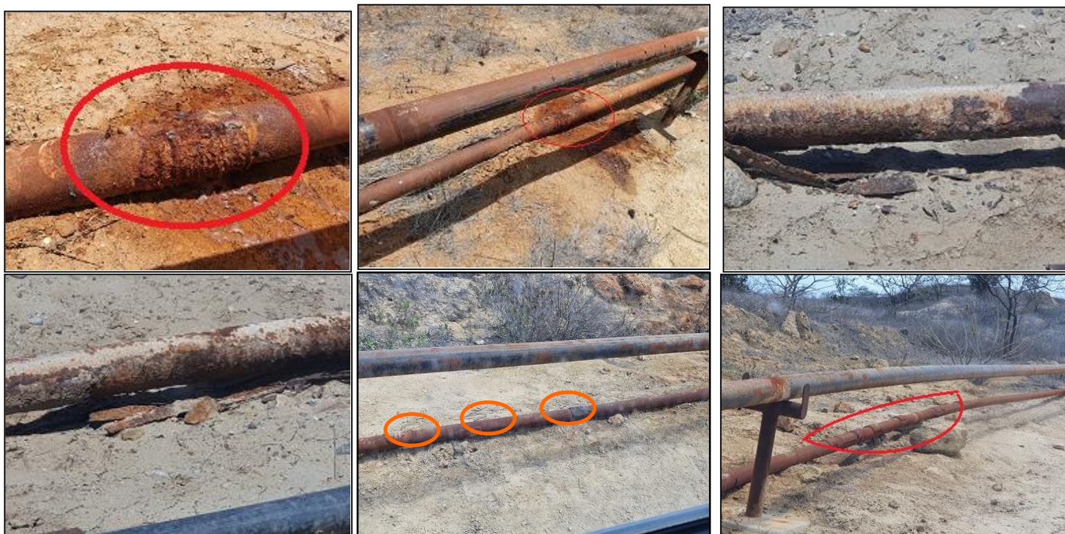
Figura 8. Galería fotográfica de la tubería del acueducto
