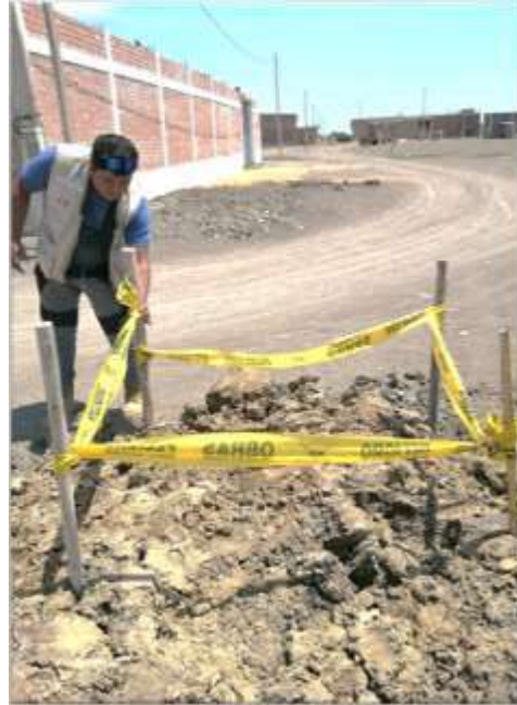
FOTO 14: TRABAJOS DE TAPADO DE CALICATAS Y SEÑALIZACIÓN
