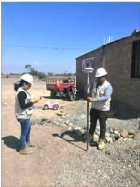
FOTO 07: TRABAJOS DE LEVANTAMIENTO TOPOGRÁFICO
