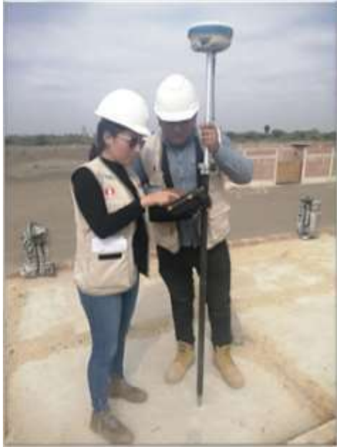
FOTO 05: TRABAJOS DE LEVANTAMIENTO TOPOGRÁFICO
