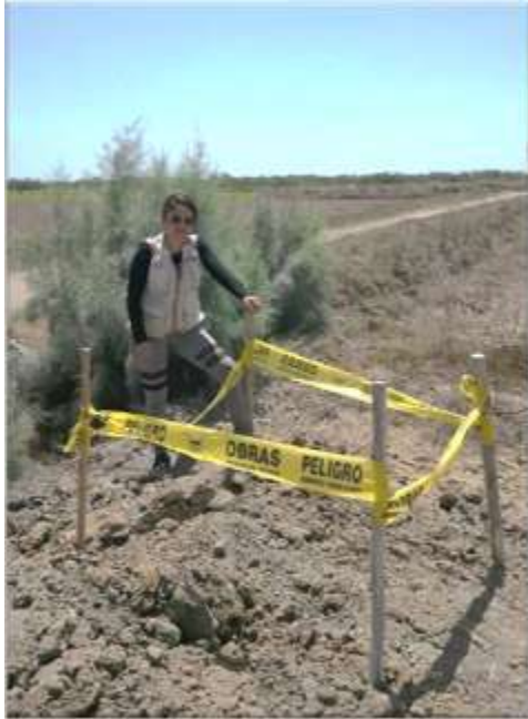
FOTO 13: TRABAJOS DE TAPADO DE CALICATAS Y SEÑALIZACIÓN
