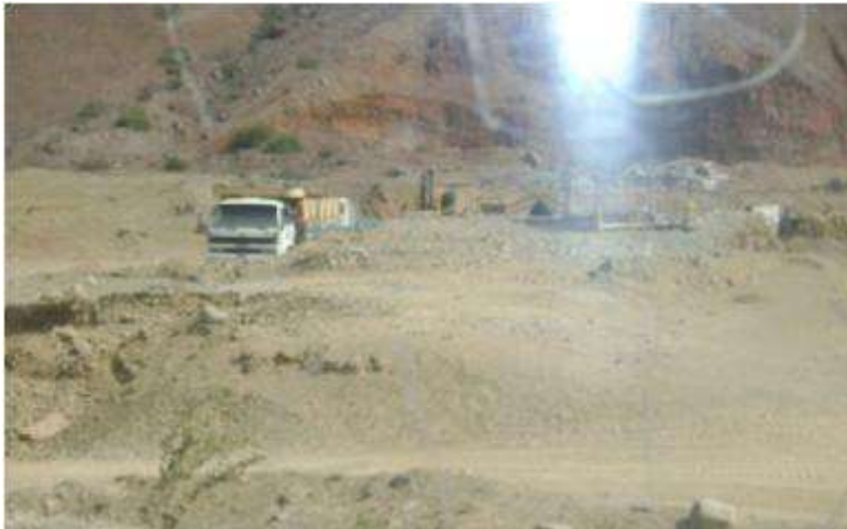
Foto 5 Cantera Tres Tomas, donde se ha previsto la instalación de la Planta de Chancado de materiales.
