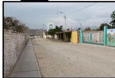
Fotografía N° 45. Las secciones viales carecen de un diseño vial adecuado y no cumplen con las dimensiones mínimas reglamentarias. Fuente: Propia
