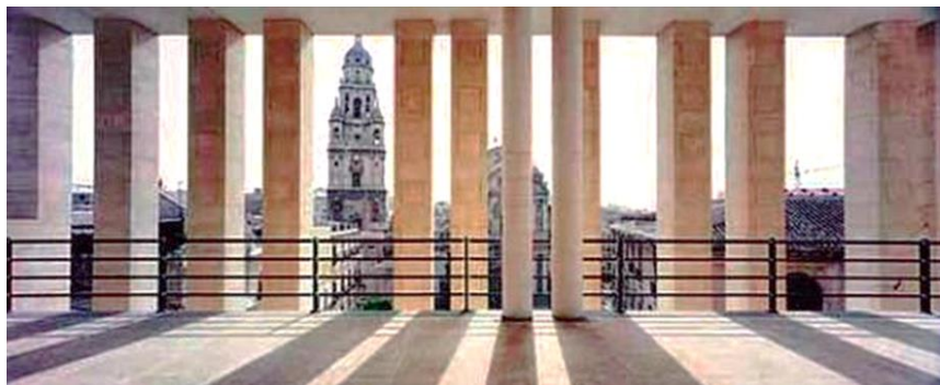
Imagen 40. La estructura de la fachada y su forma genera un sol y sombra que protege de la incidencia solar directa.
