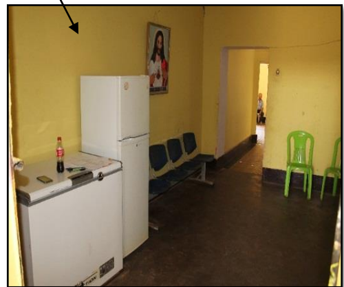
Fotografía N° 18 Hall Area de 18.09 m 2 paredes de adobe, techo caña barro y piso de cemento pulido. Fuente: Propia
