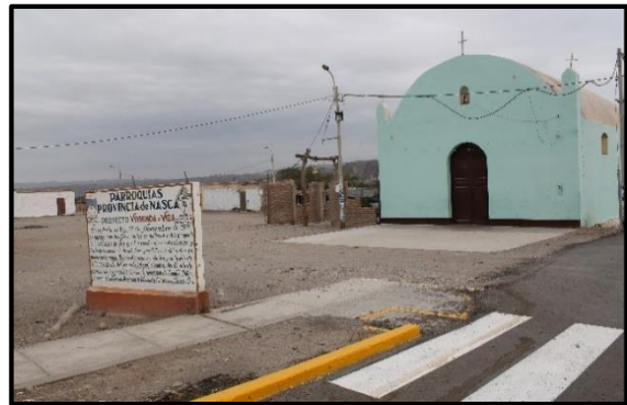
Fotografía N° 39. Inadecuado diseño del acceso al atrio de la Capilla, dificultando la transitabilidad de sus peatones. Fuente: Propia
