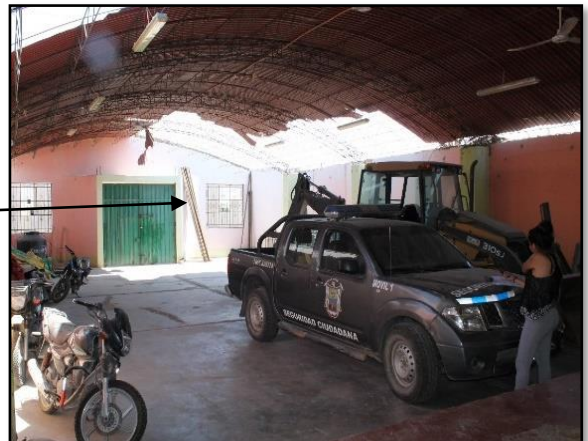
Fotografía N° 25 Salón de Usos Múltiples Área de 233.91 m 2 paredes de adobe, techo de armadura metálica y piso cemento pulido. Fuente: Propia
