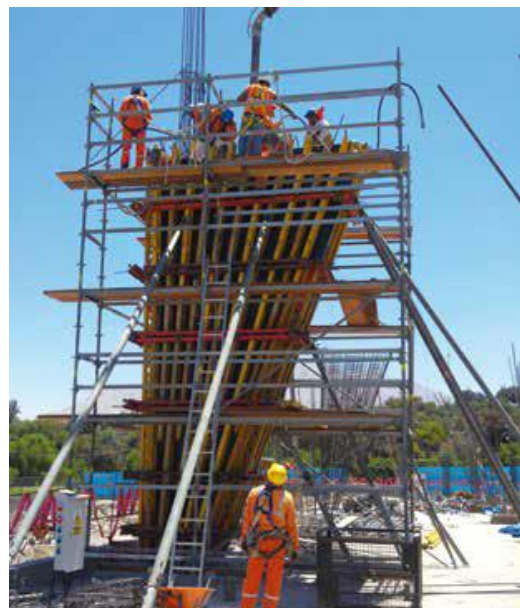
Imagen 19. (arriba) Encofrado de las columnas trapezoidales que conforman la estructura del edificio.
