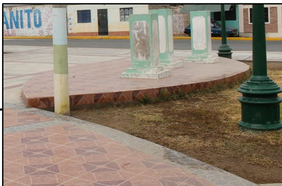
Fotografía N° 34. Falta de mantenimiento de las áreas verdes, generando mal aspecto y disminuyendo el índice de áreas verdes por habitante requerido por la OMS. Fuente: Propia
