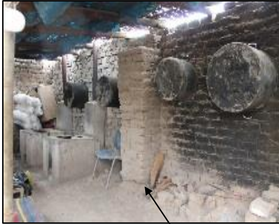
Fotografía N° 27 Cocina Paredes de adobe, techo de caña y piso de terreno natural. Fuente: Propia
