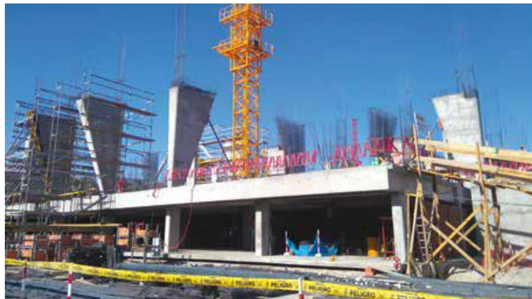
Imagen 21. Desencofrado de las columnas de forma trapezoidal. Fuente: Tomado de Perú Construye (2018) Edición 54, p. 51
