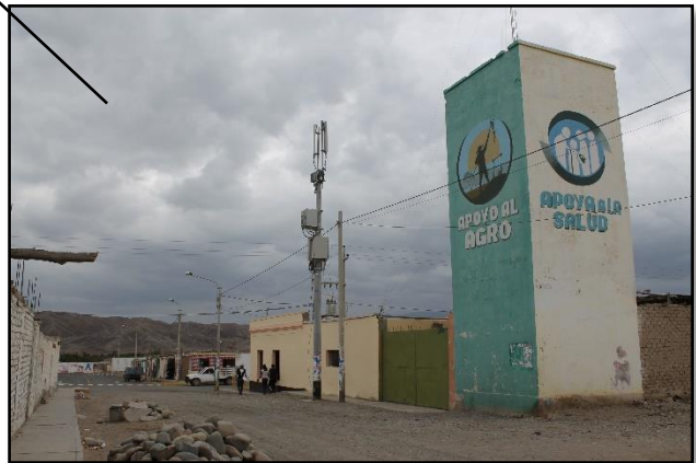
Fotografía N° 11 Fachada de Calle Eloy Valencia. Fuente: Propia
