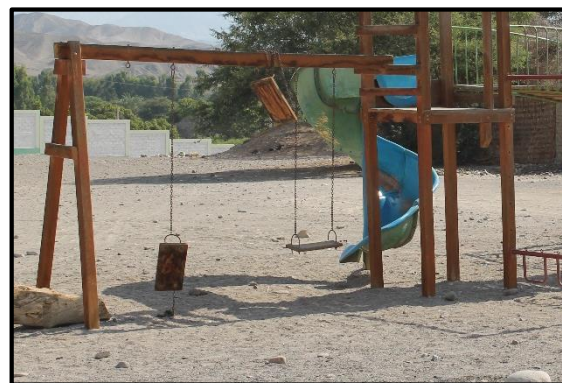
Fotografía N° 37. Los juegos para niños se encuentran generalmente en desuso debido a su deterioro y falta de mantenimiento, atentando contra la integridad física de los niños. Fuente: Propia
