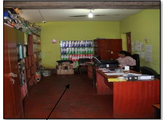
Fotografía N° 20 Alcaldía Area 18.75 m 2 paredes de adobe, techo de caña con barro, piso cemento pulido. Fuente: Propia
