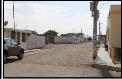
Fotografía N° 44. La falta de señalización en los cruces de las vías resulta perjudicial para los habitantes, generando posibles accidentes de tránsito. Fuente: Propia
