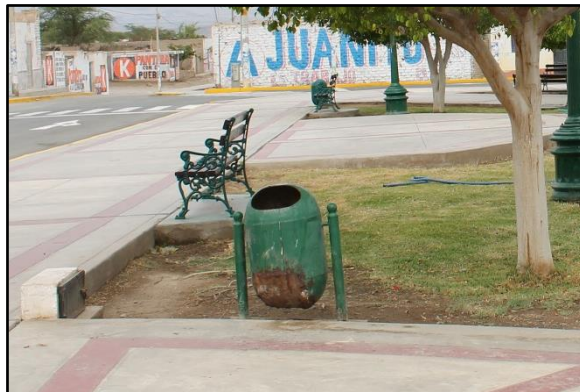
Fotografía N° 31. Mobiliario urbano deteriorado, debido a su mala ubicación y sin protección contra la humedad de las áreas verdes, perjudicando el óptimo uso de sus habitantes. Fuente: Propia
