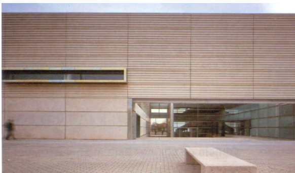
Imagen 46. Fachada lateral del edificio Fuente: Tomado de Revista Arquitectura (2000). N° 321, p. 29
