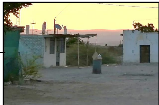
Fotografía N° 41. El espacio de reunión se ha convertido en acopio de residuos sólidos acumulado por sus ocupantes. Fuente: Propia
