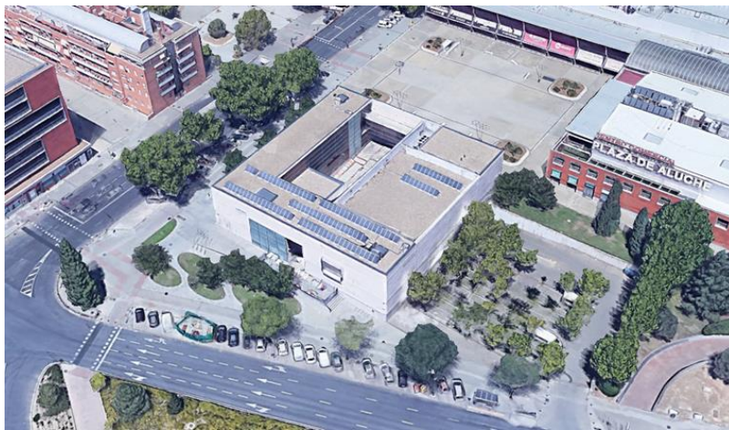
Imagen 44. La forma prismática de base cuadrada del edificio ordena los elementos que conforman su entorno. Fuente: Google Earth 2020
