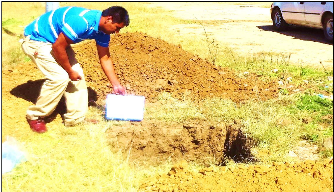
FOTO N°01: Excavación de la Calicata N°01 en el Sector 24 la Villa de Huacariz-Cajamarca con 1m de ancho, 1m de largo y 1.50m de alto
