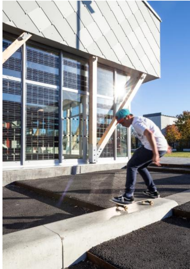
Figura 11. Pabellón deportivo - Rotebro
