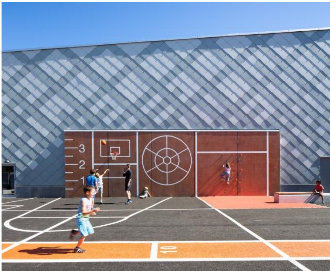
Figura 10. Pabellón deportivo - Rotebro
