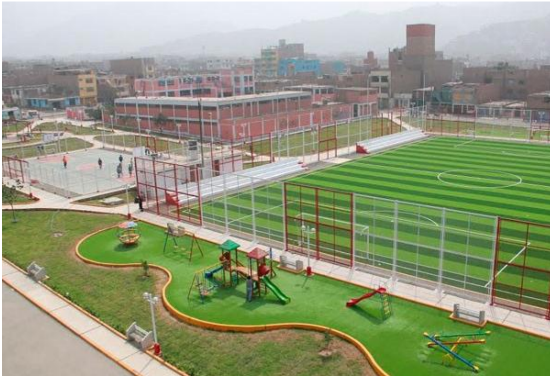
Figura 39. Parque N° 2 de la Cooperativa de Vivienda Huancara
