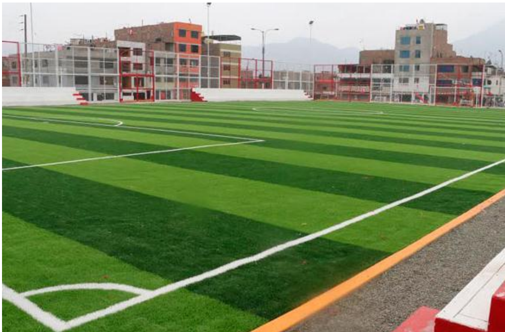
Figura 41. Parque N° 2 de la Cooperativa de Vivienda Huancara
