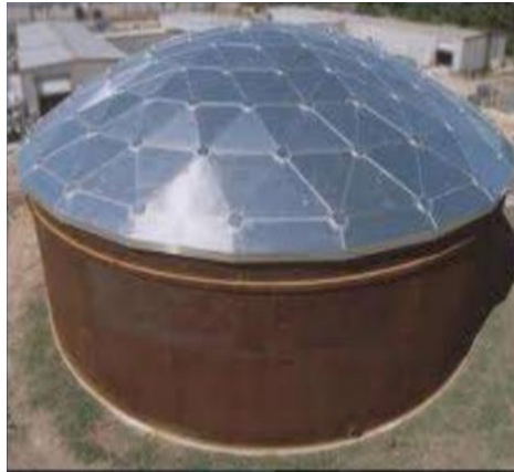
Figura 2. Tanque de Almacenamiento vertical.
