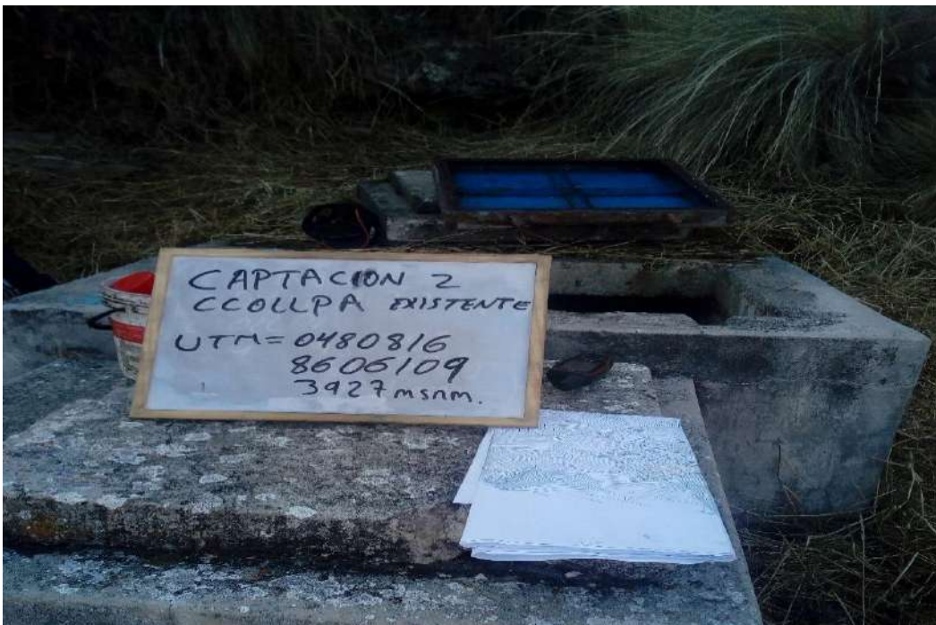
Fig N° 06 VISTA DE LA CAPTACION EXISTENTE 2 CCOLLPA
