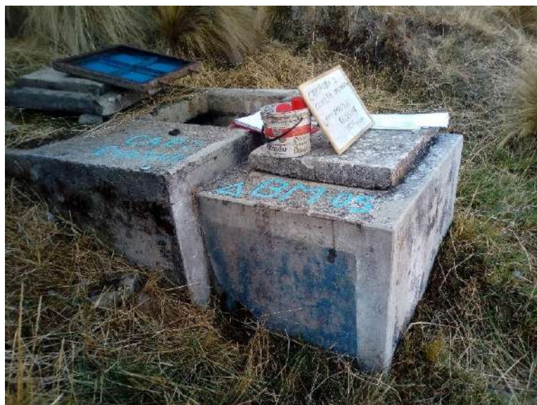
Figura 12. Captación Existente.
