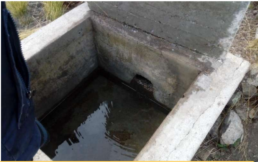
Fig N° 04 VISTA DE LA CAPTACION EXISTENTE DE COLLPA
