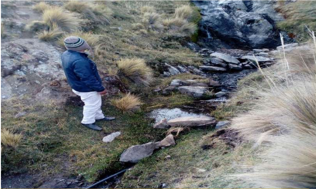
Fig N° 05 VISTA DE LA TOMA DE AGUA
