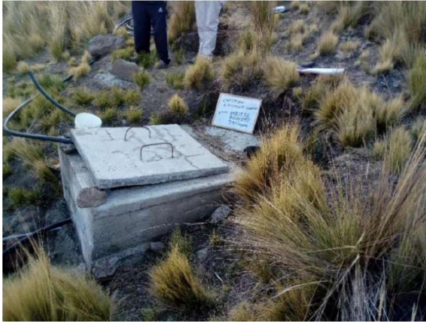
Figura 17. Estado situacional de la captación Collpa.
