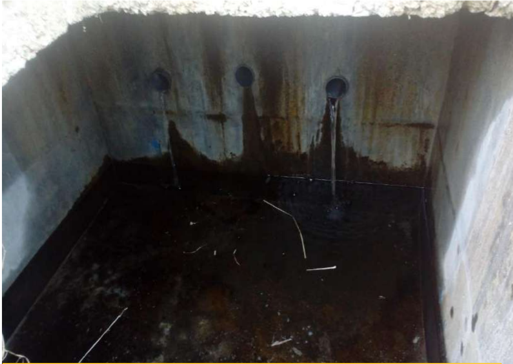
Fig N° 07 VISTA DE AGUJEROS A LA CAMARA HUMEDA
