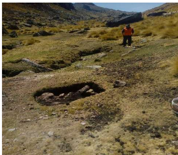
Figura 15. Muestra de calicata en la línea de conducción.
