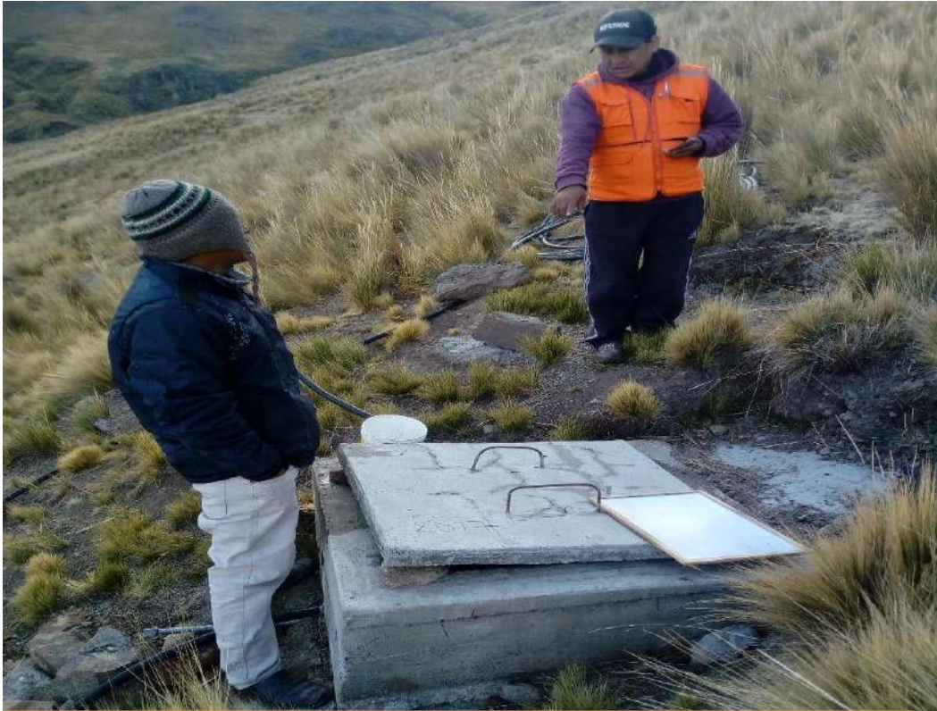
Fig N° 03 VISTA DE LA CAPTACION EXISTENTE DE COLLPA
