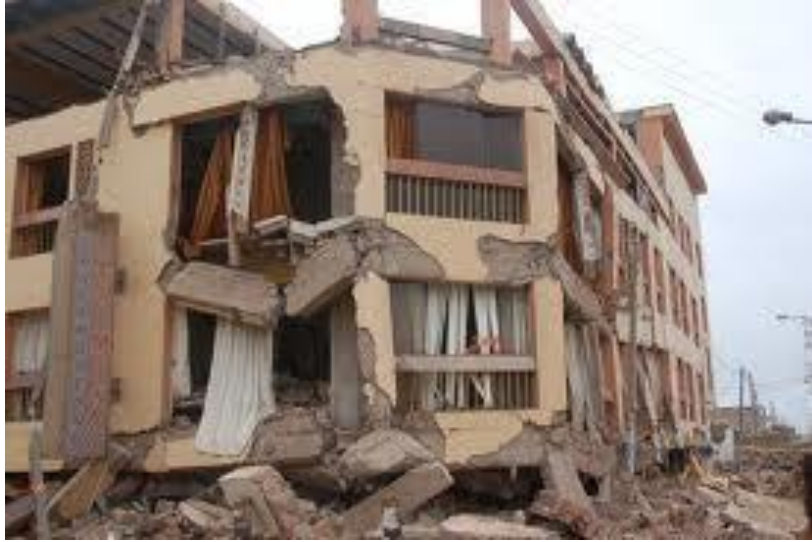
Institución educativa colapsada en el sismo de Pisco
