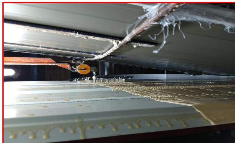
Figura 26. Inyección de la mezcla
