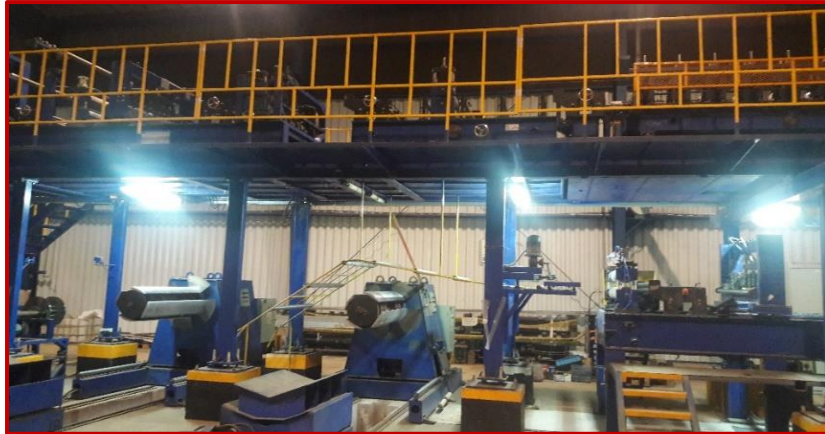
Figura 23. Roll forming por donde pasa las planchas metálicas
