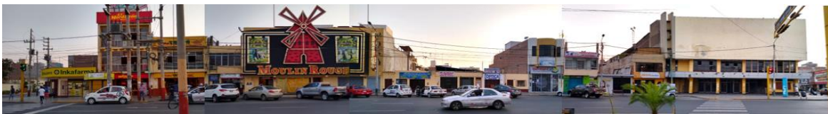
Figura 6: PERFIL 1 - AV. JOSE PARDO Fuente: Fotografía Propia
