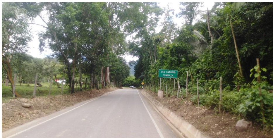
Figura 4: Vía Principal de San Antonio de Cumbaza
