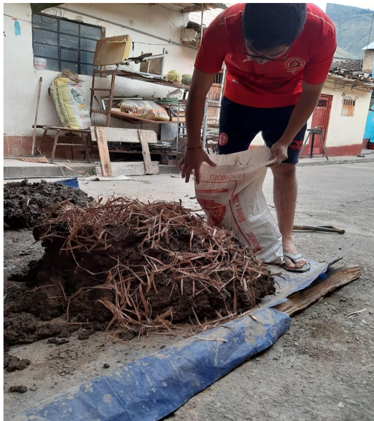
Fotografía 30: mezclado del barro con fibras de eucalipto
