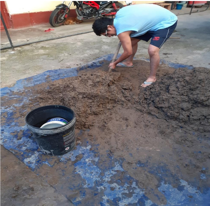
Fotografía 28: preparación del barro para adobes
