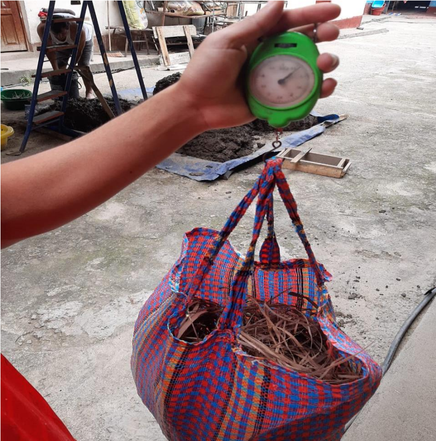
Fotografía 28: preparación del barro para adobes
