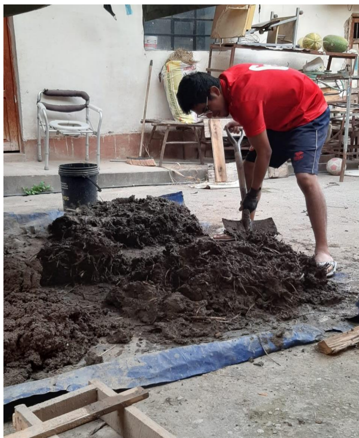
Fotografía 30: mezclado del barro con fibras de eucalipto
