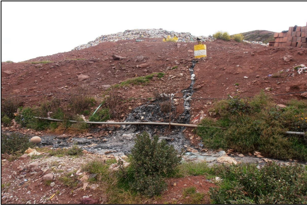
Fotografía N° 01: Presencia de lixiviados provenientes de las plataformas superiores.
