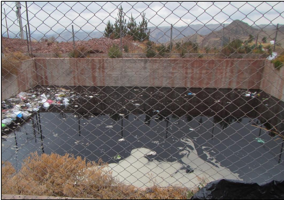
Fotografía N° 05: Poza de almacenamiento de lixiviados, ubicado en la parte media del Botadero, el mismo que fue construido con material noble.
