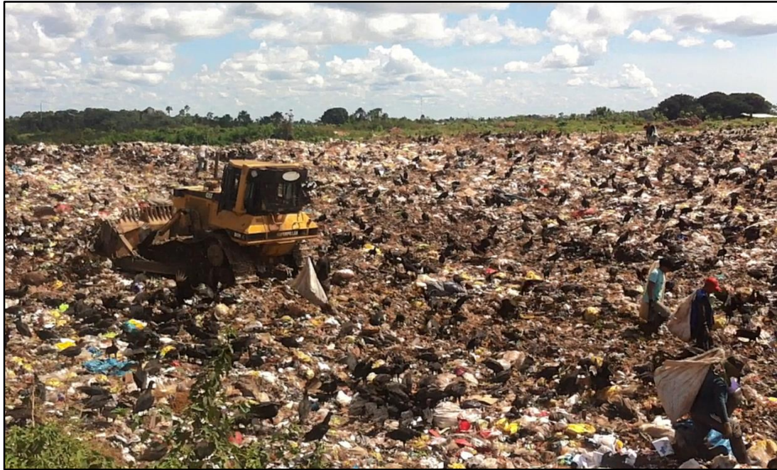
Fotografía N° 11: Actividad de segregación, presencia de gallinazos y maquinaria pesados nivelando y compactando los residuos.
