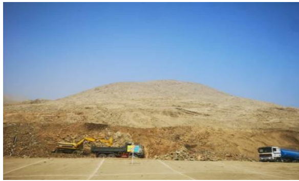
Figura N°22. Traslado de agregados finos de cantera Gloria Grande Ate – Vitarte.
