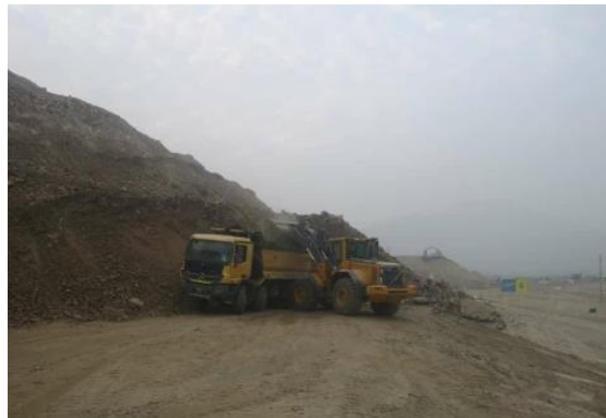
Figura N°21. Traslado de agregados de cantera Gloria Grande Ate – Vitarte.
