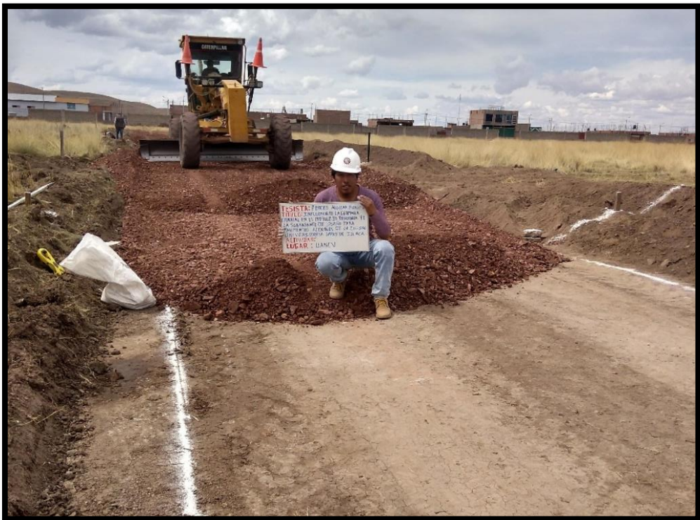
Ilustración N° 06. Conformación y nivelación del material de relleno para una altura de 0.30mts.
