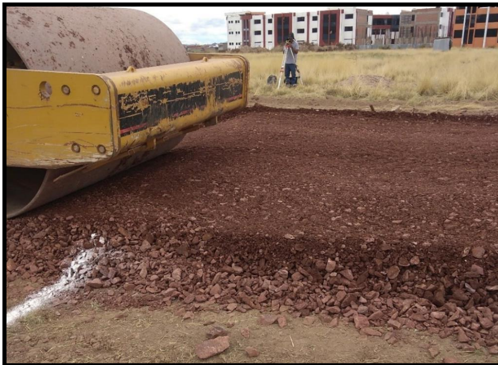
Ilustración N° 09. Compactación de la subrasante con una altura de 0.30mts.
