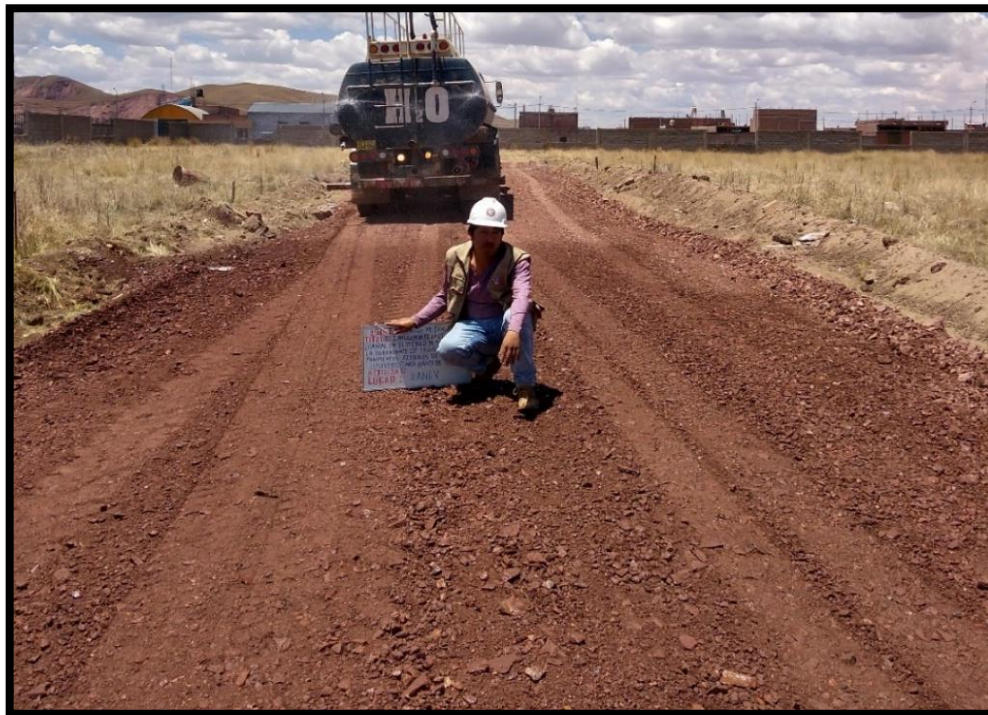
Ilustración N° 07. Camión cisterna humedeciendo el material.
