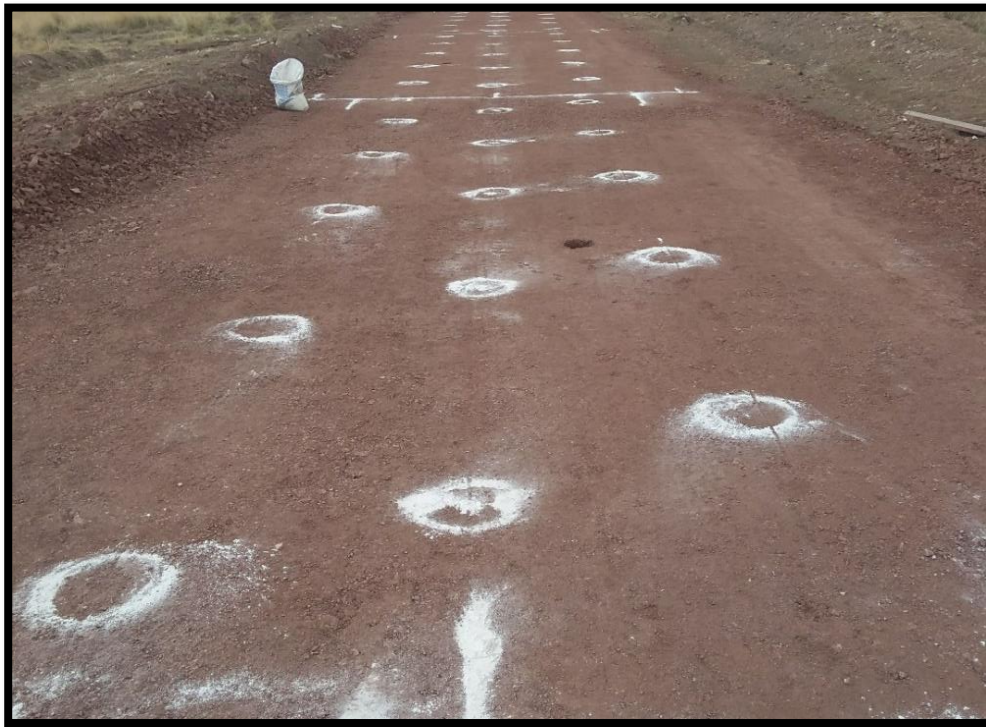
Ilustración N° 13. Toma de puntos en los bordes y en el centro del carril.
