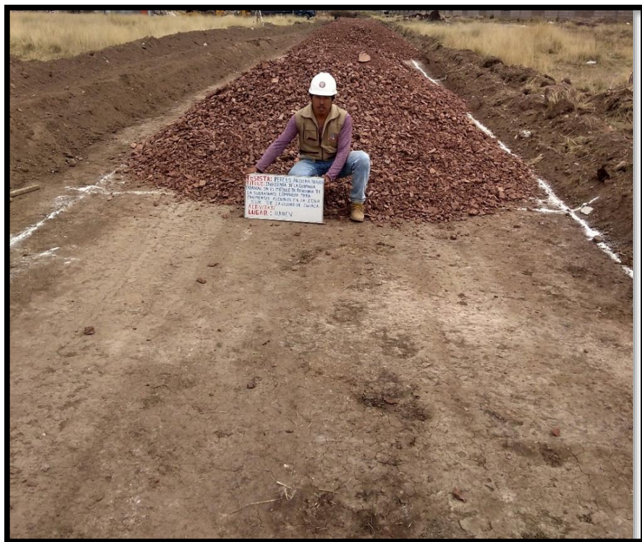
Ilustración N° 02. Material de relleno para la capa de mejoramiento.
