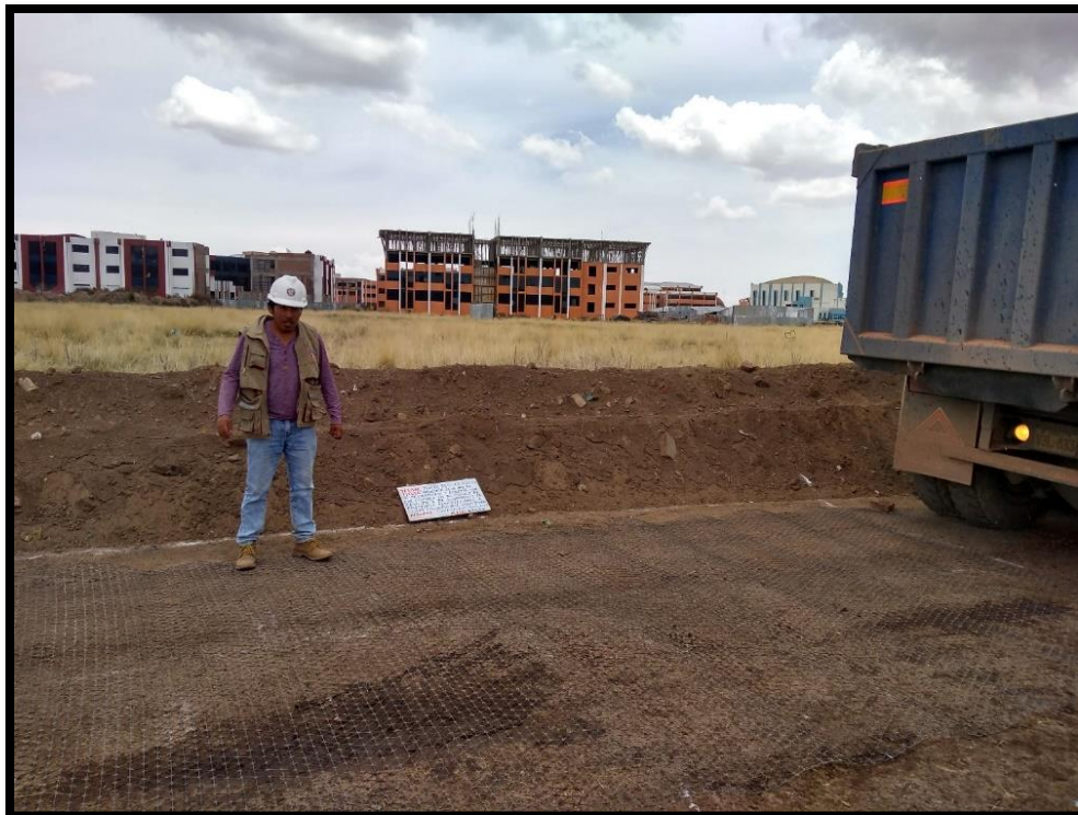
Ilustración N° 03. Colocado de la geomalla triaxial en el suelo natural.
