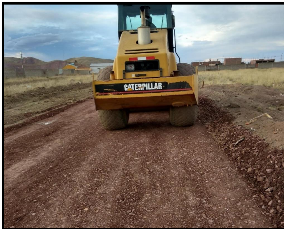
Ilustración N° 08. Compactación de la subrasante.
