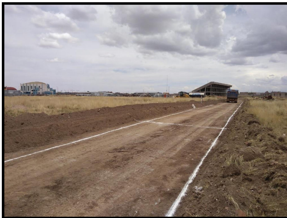
Ilustración N° 01. Perfilado de 0.15mts de material orgánico.
