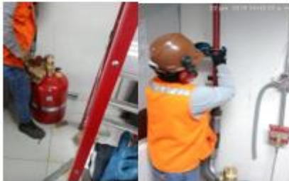
• Instalación de balón Noverc 1230 y conexiónado final.
