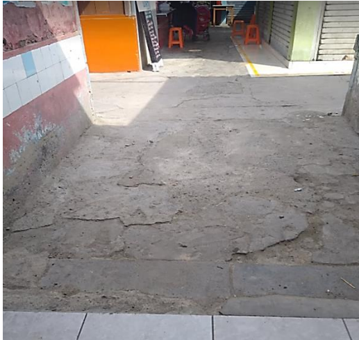
Figura 2: Pisos interiores de los pasadizos.
