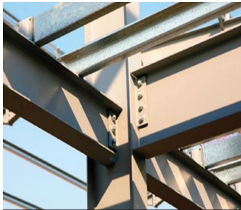
Figura 75: Uniones de vigas,
