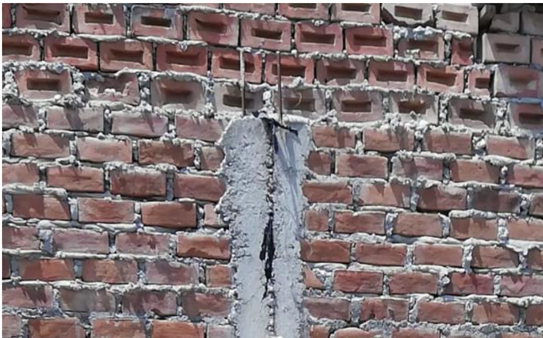
Discontinuidad de columna de confinamiento y cambio de aparejo en el asentado de la unidad de albañilería.
