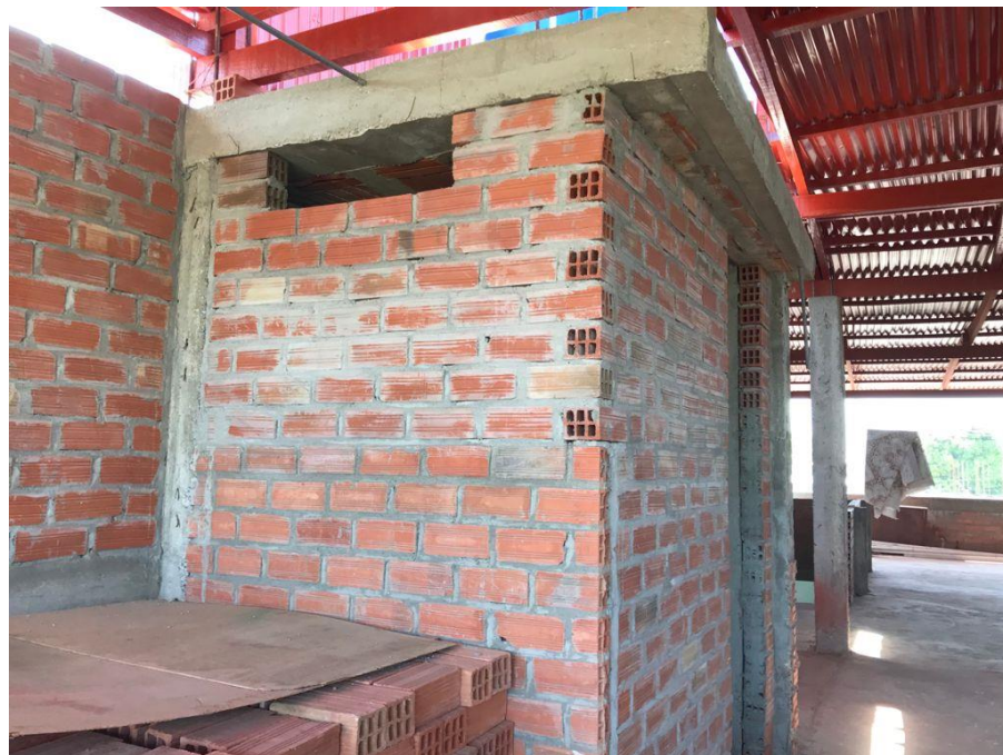
Deficiencias en la mano de obra, evidenciadas en cangrejas en los elementos estructurales.
