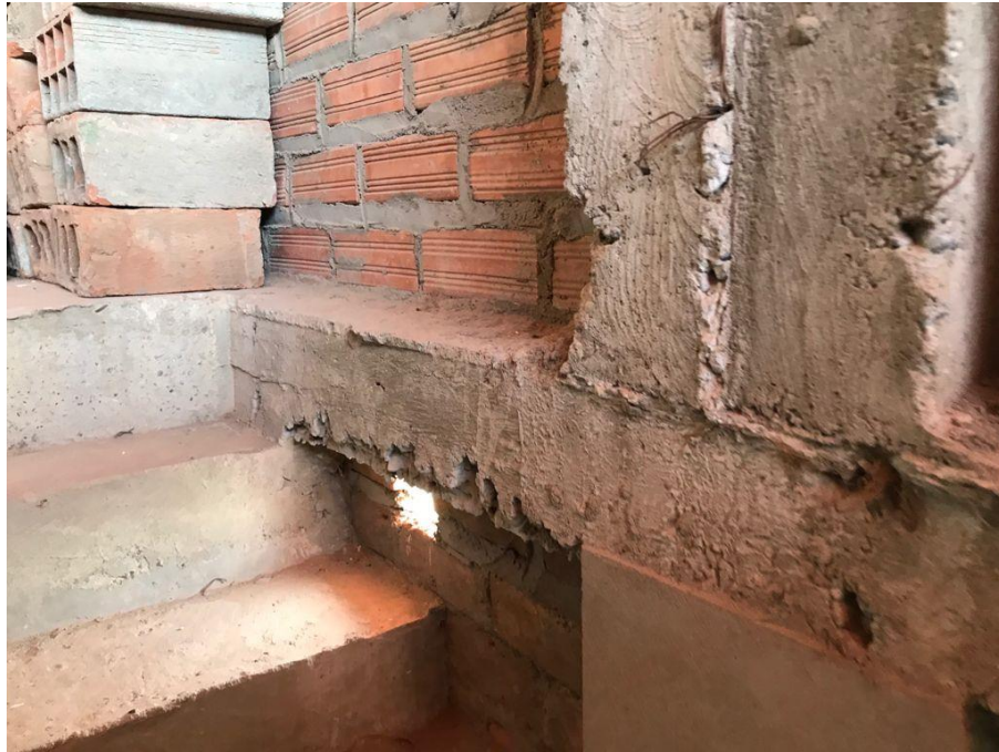
Deficiencias en la mano de obra, evidenciadas en cangrejas en los elementos estructurales.
