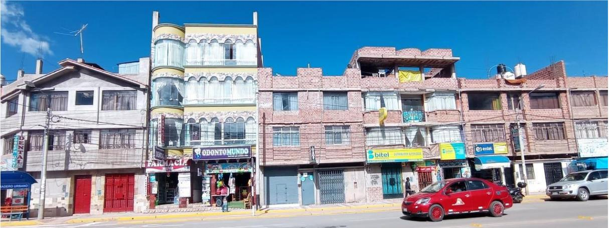
En las imágenes, podemos apreciar que las edificaciones no cuentan con juntas sísmicas, y que debido a ello no permitirán que las edificaciones tengan un comportamiento sísmico independiente, generando así daños en todas las estructuras.
