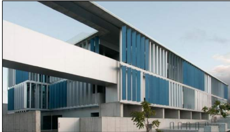
Figura 112: Fachada con protección de lamas verticales.
