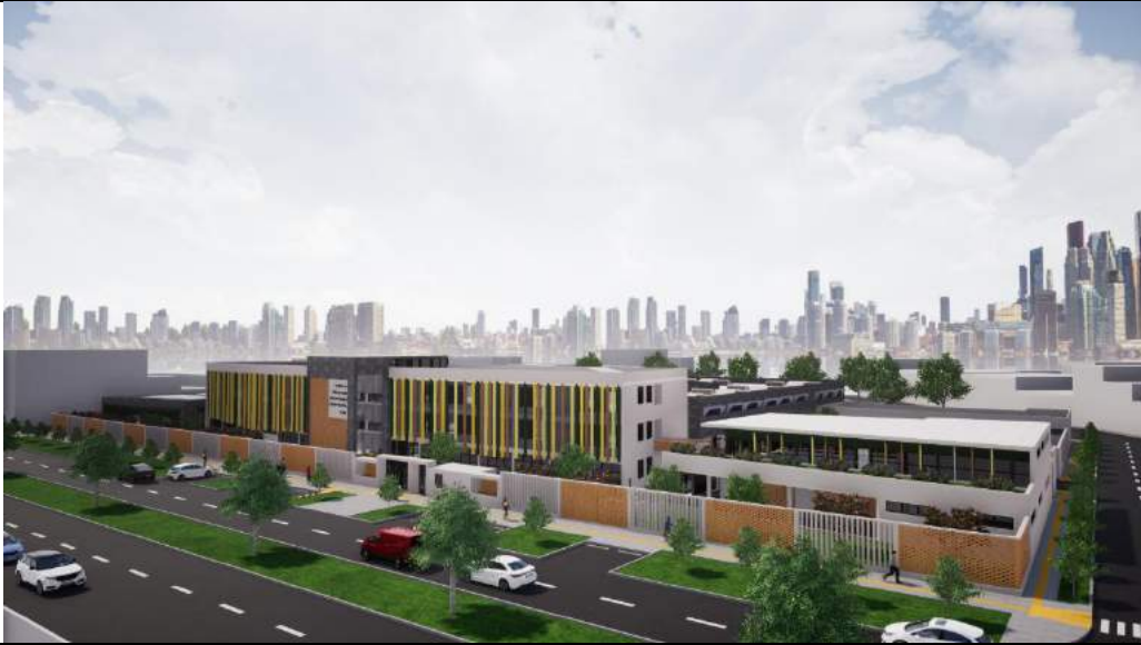
Fachada principal (Vista en perspectiva)
