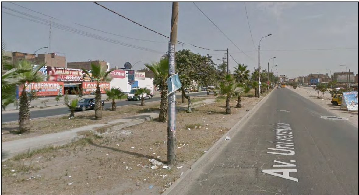
Ilustración 9 Estado actual berma central, avenida Universitaria.
