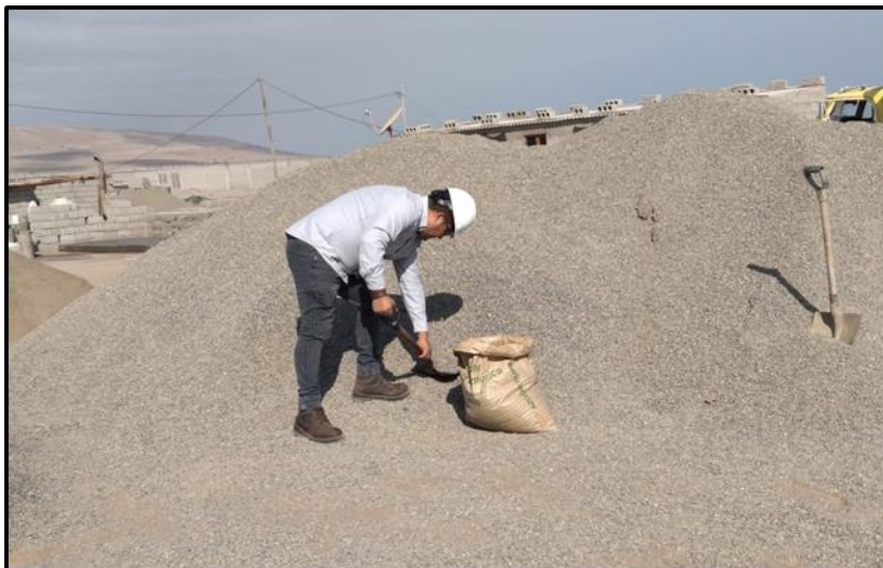
Imagen 04: Acarreo de agregado fino y grueso de la cantera.
