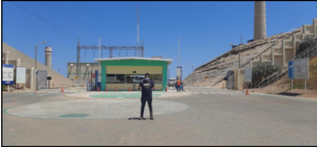
Imagen 01: Entrada de la planta termoeléctrica de Engie.
