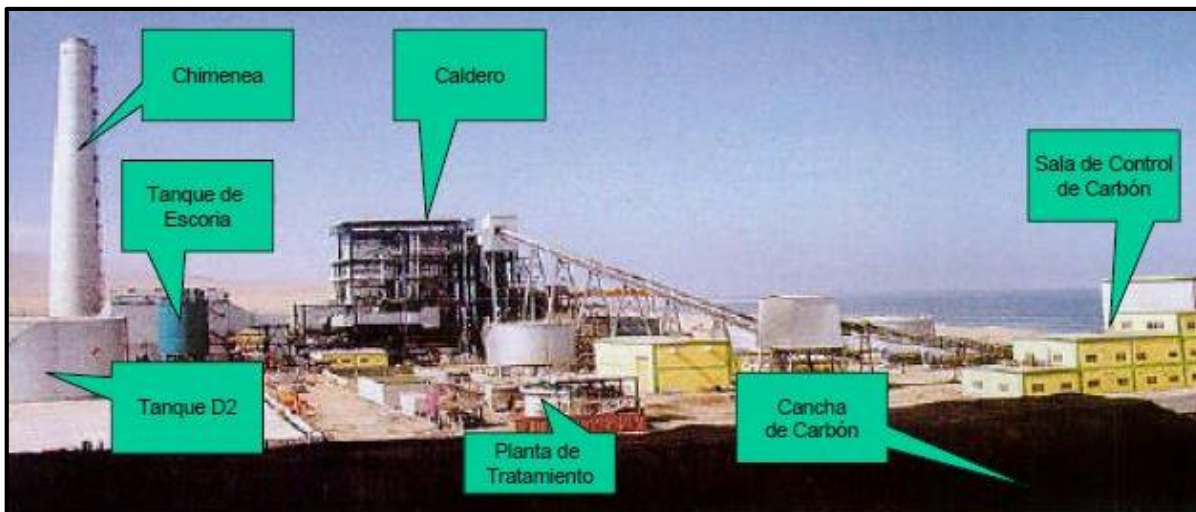
Figura 11: Esquema de la planta termoeléctrica en Ilo. Adaptado de Engie, 2016.
