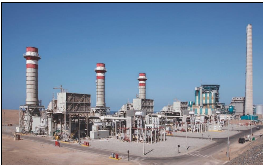
Figura 12: Planta termoeléctrica de Ilo. Adaptado de Engie, 2016.
