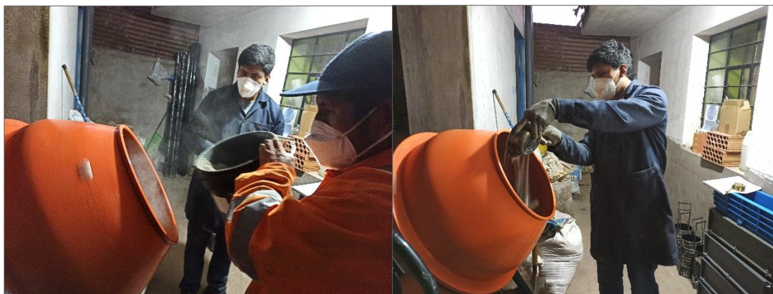
Figura 14. Proceso de elaboración del concreto
