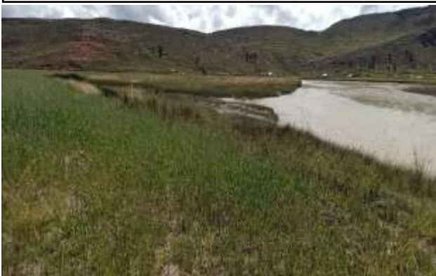
Fotografía 5. Zona afectada en máximas avenidas, ubicada en el tramo 3 + 209 km
