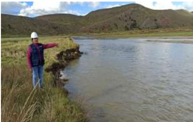
Fotografía 3. Zona Inundable, ubicada en el tramo 3+209 km
