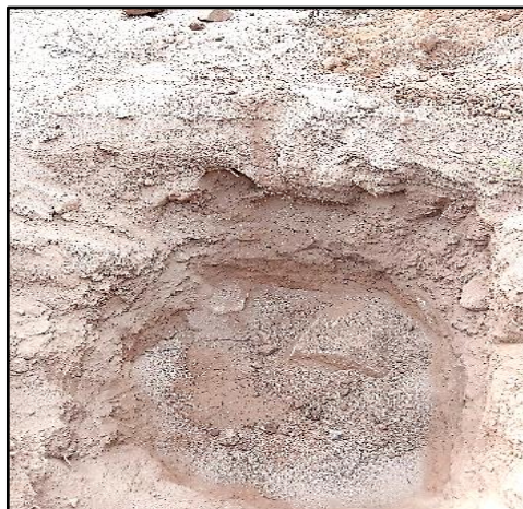
Figura 10 Excavación de la calicata
