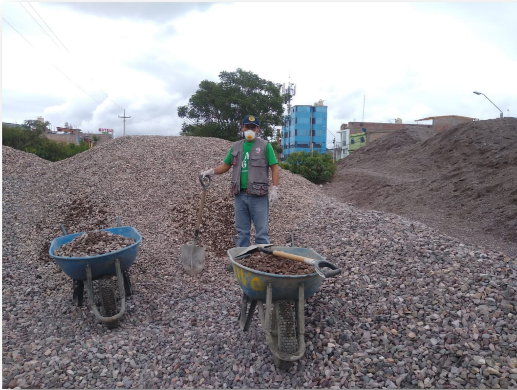
FOTO 1: Realizando traslado de agregado grueso y fino
