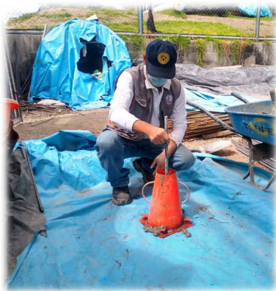
FOTO 8: Ensayo de asentamiento
