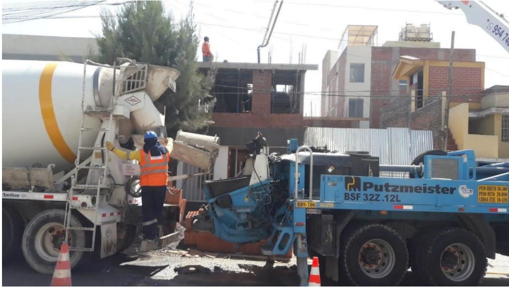
Imagen 5: Concreto puesto en obra
