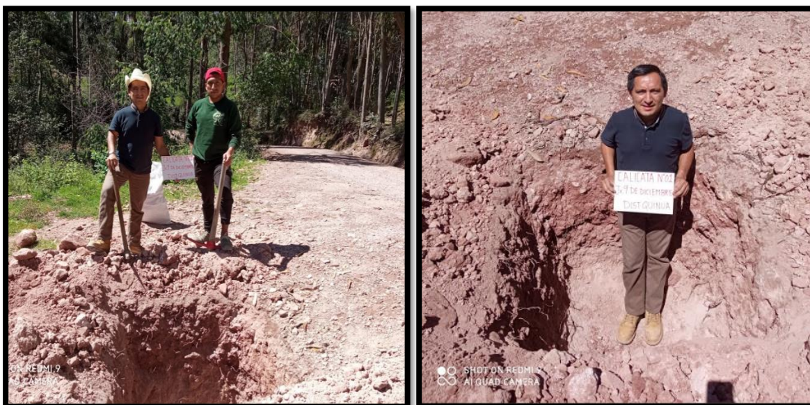
Figura 18. Calicata en sitio M-01
