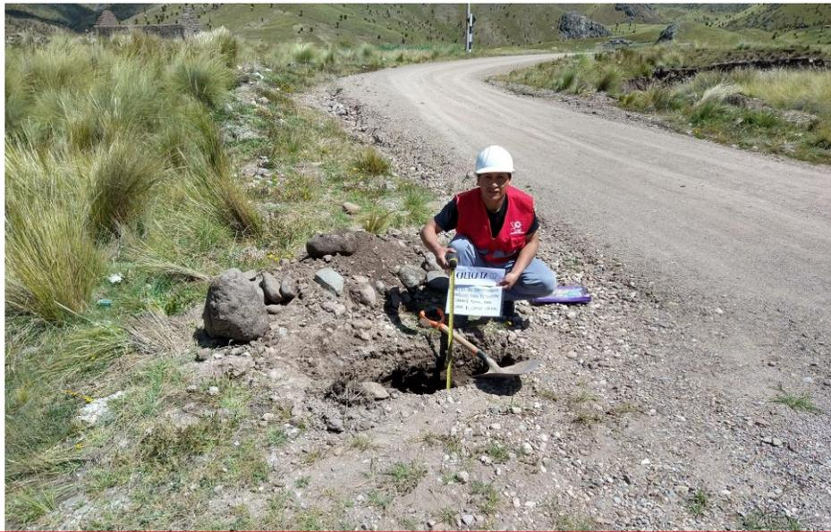
**FOTO 3:** Se puede observar la excavación de la CALICATA 2 en la progresiva 23+500 de lado izquierdo.
