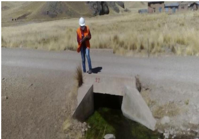
**FOTO 11:** Se puede apreciar tomando datos de las alcantarillas existentes en el camino vecinal en la progresiva 18+500.
