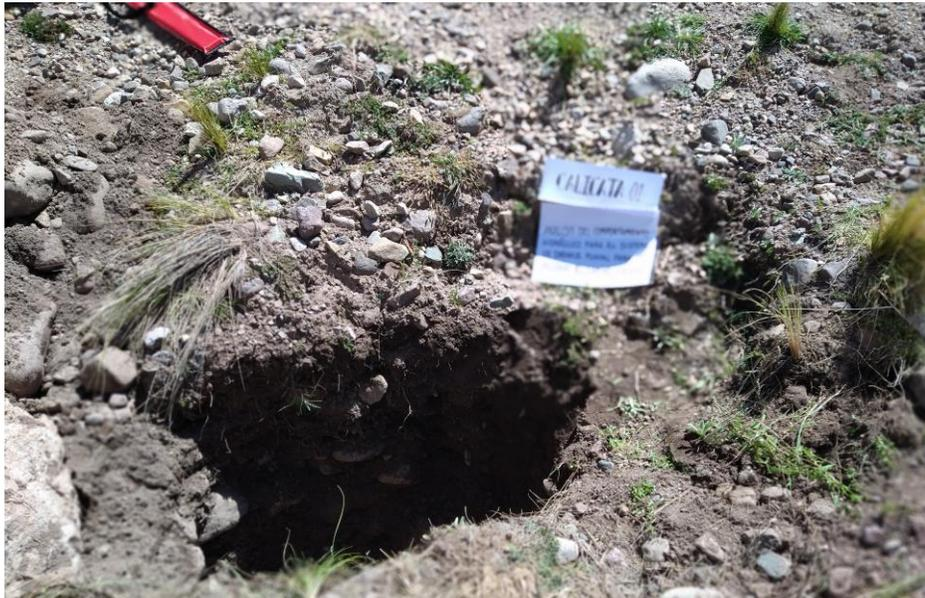
**FOTO 2:** Se puede observar la excavación de la CALICATA 1 en la progresiva 23+480 de la zona de estudio.
