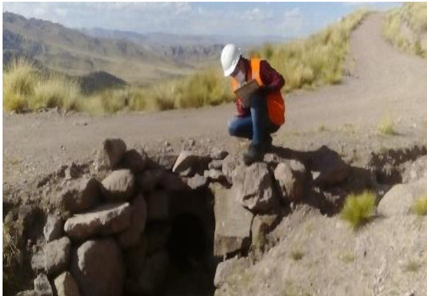
**FOTO 13:** Se puede apreciar tomando datos de las alcantarillas existentes en el camino vecinal en la progresiva 29+680.
