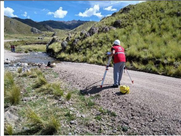
Se observa, realizando el trabajo de campo tomando datos topográficos de la progresiva km 23+480 lugar a intervenir.
