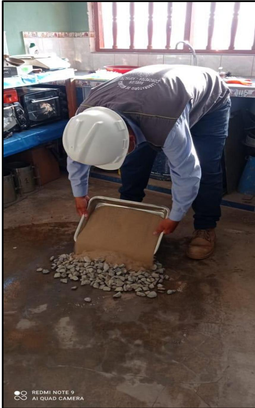
**Figura 12.** Colocación de los agregados para realizar el diseño de concreto convencional
