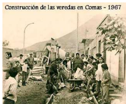
Figura 55. Construcción de Veredas en Comas, 1967.
