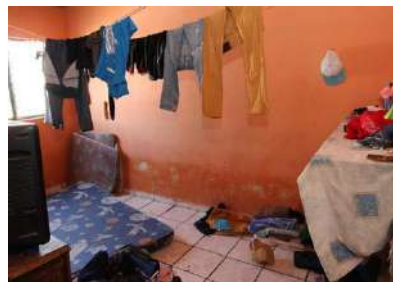
Figura 34. Centro de Rehabilitación en México - Servicios Higiénicos.
