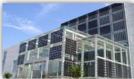
Figura 4. Sistema fotovoltaico integrado (BIPV). Fuente: Gramas.
