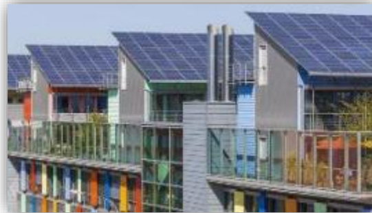
Figura 3. Sistema Paneles Fotovoltaico. Fuente: EcoHabitar.
