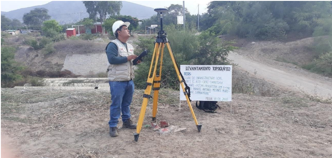
Foto N° 1: Colocación de Bm's
