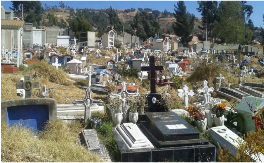
Figura 1: Estado actual del Cementerio General Presbítero Pedro García Villón. Huaraz
